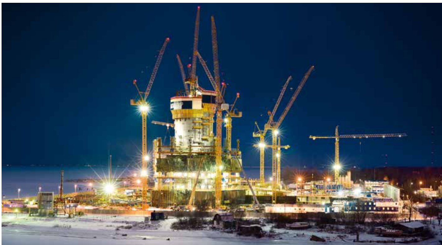
Zehn Liebherr-Turmdrehkrane am Lakhta-Tower bei Nacht.
