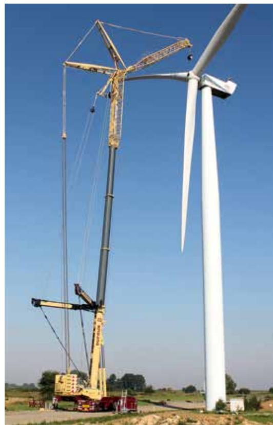
Zum Ersteininsatz ging es für den LTM 1750-9.1 nach Aisne in Frankreich, wo der Kran bei der Montage einer 2,75 MW-Windkraftanlage eingesetzt war.
