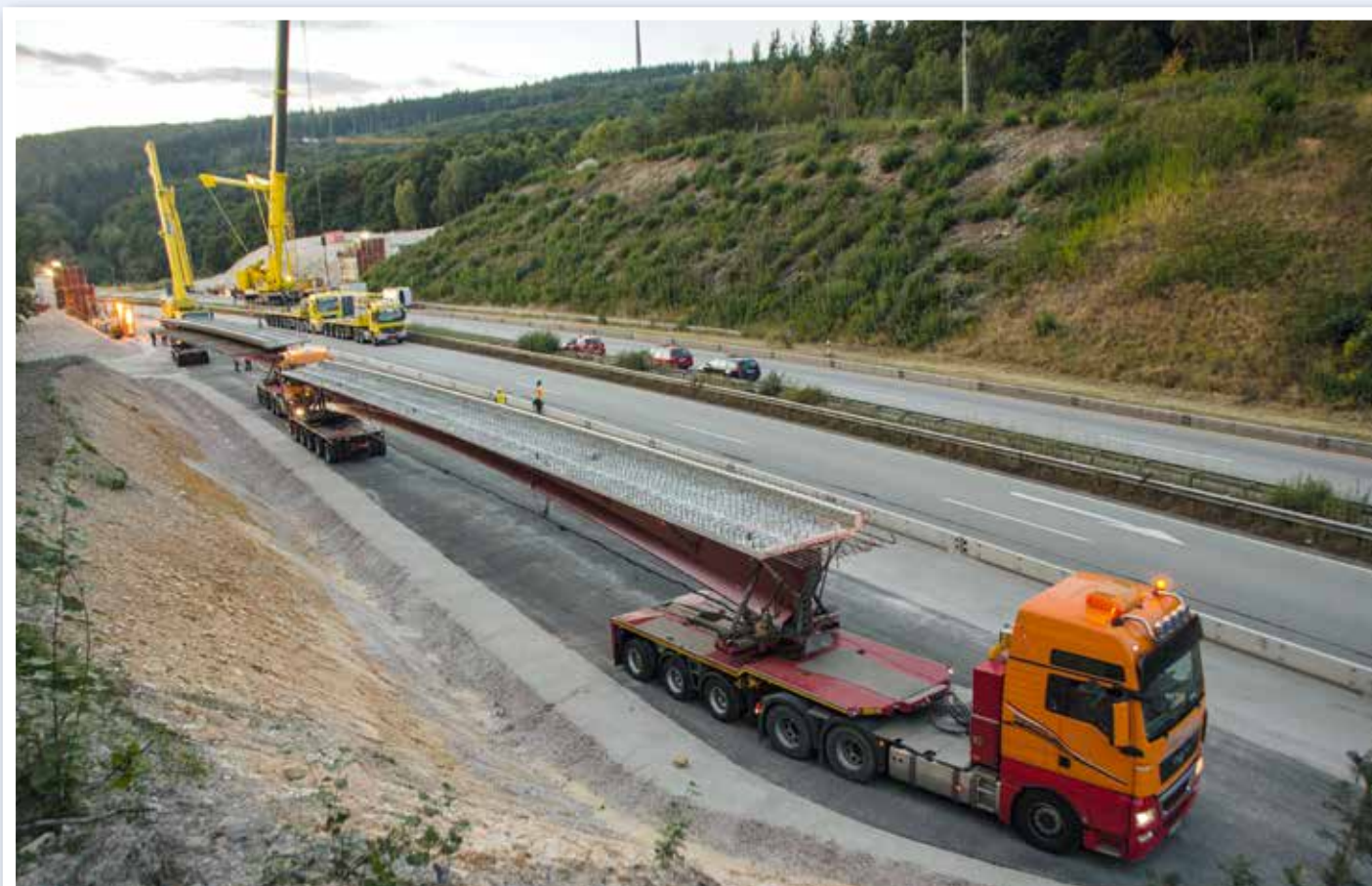
Herausforderung Brückenbau. Jetzt schon und auch in den kommenden Jahren wird der Neubau und die Sanierung von Brücken der Kran- und Schwertransportbranche zahlreiche Aufträge bescheren. Bild: Michael Bergmann
