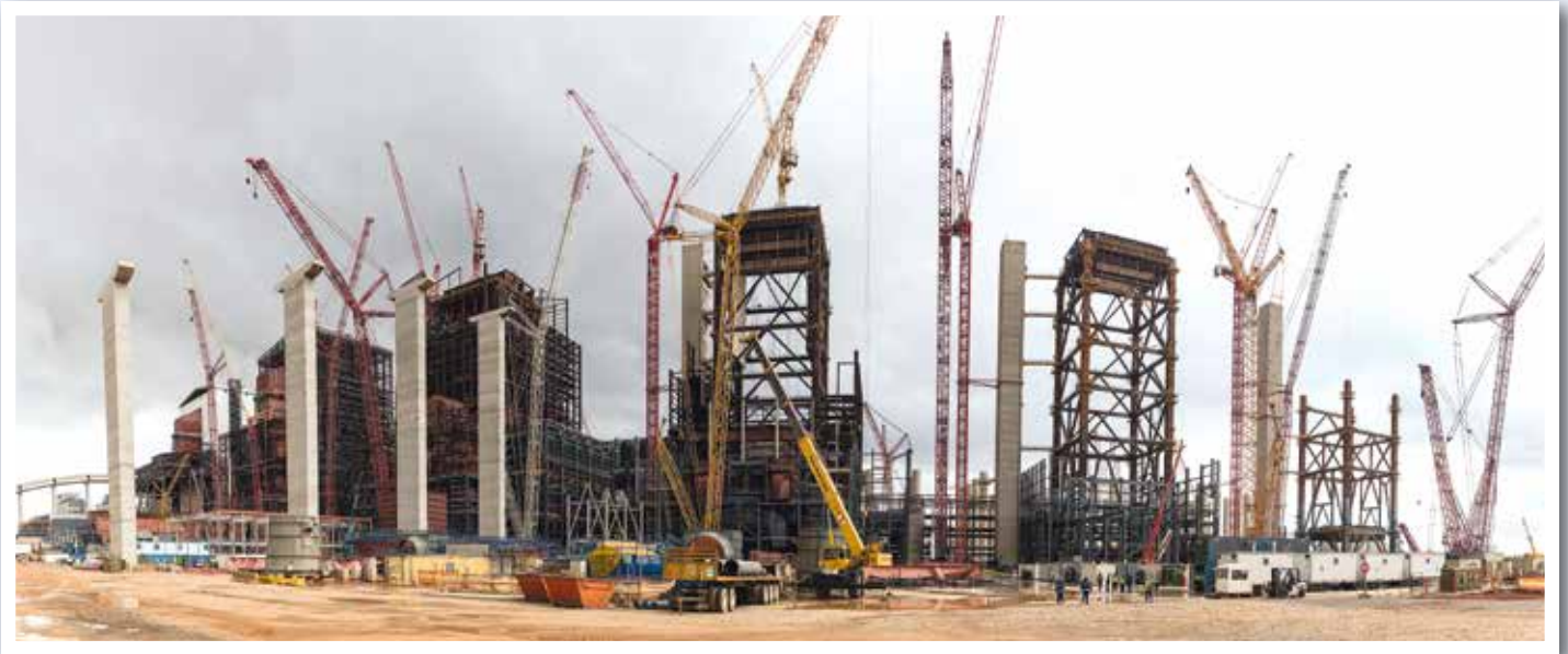
Insgesamt sieben Wolffkrane sind auf dieser Kraftwerksbaustelle in Südafrika im Einsatz.
