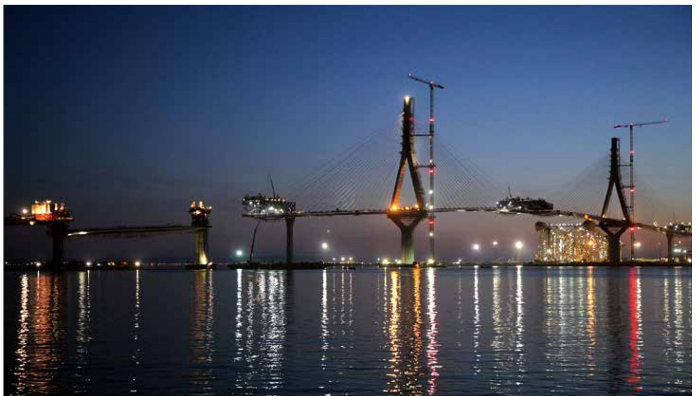
Bei ihrem Einsatz an der „Puente de la Pepa“ klettern die beiden Comansa 21LC400 auf eine maximale Höhe von 195,6 m. Zuvor wird einer der beiden Turmdrehkrane per Mobilkran von einem Ponton aus aufgebaut.
