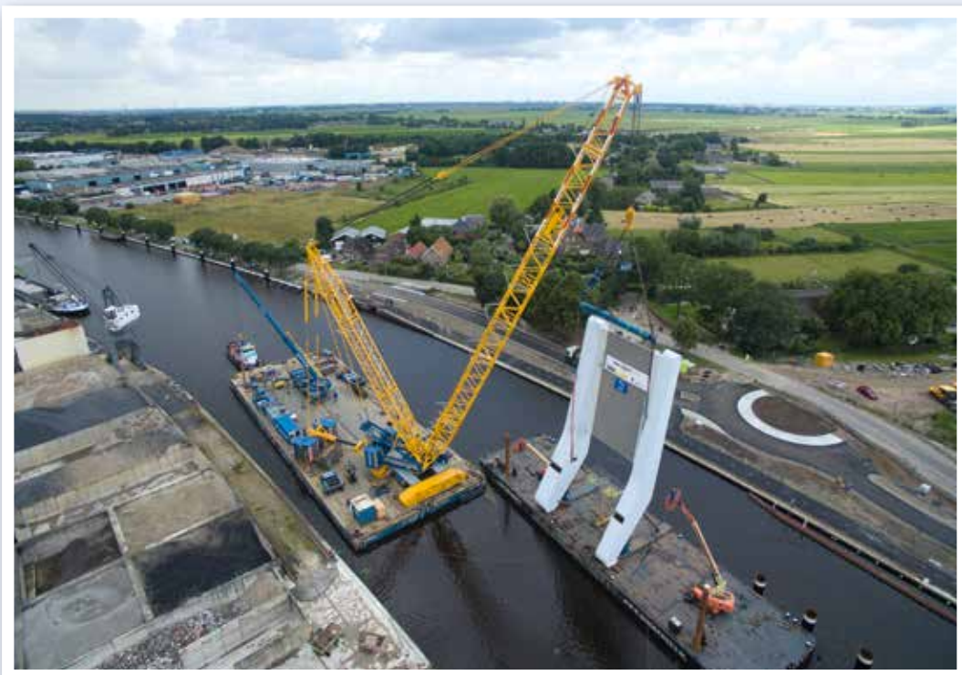
Der Demag CC 3800-1 steht auf dem einen Ponton, der Superlift-Tray mit maximalem Gegengewicht auf dem zweiten Ponton platziert. Beide Pontons sind für den Hub miteinander verbunden, fahren zuvor aber hintereinander an den Einsatzort.
