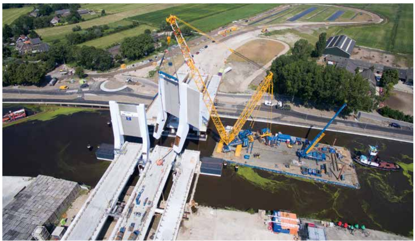
Der Demag CC 3800-1 steht auf dem einen Ponton, der Superlift-Tray mit maximalem Gegengewicht auf dem zweiten Ponton platziert. Beide Pontons sind für den Hub miteinander verbunden, fahren zuvor aber hintereinander an den Einsatzort.
