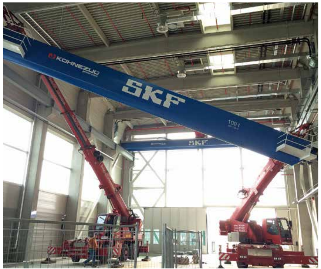
Zentimeter um Zentimeter wird einer der beiden Querträger im Tandemhub auf seine Laufschiene in gut 12 m Höhe gehoben.
