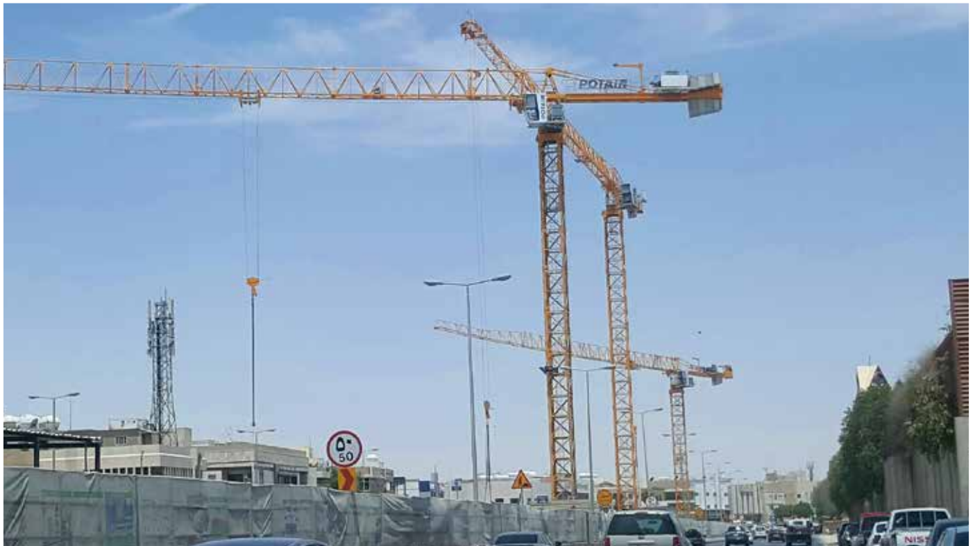
Teamwork in Riad: 28 Potain-Krane sind beim Bau der längsten Metro des Mittleren Ostens im Einsatz.
