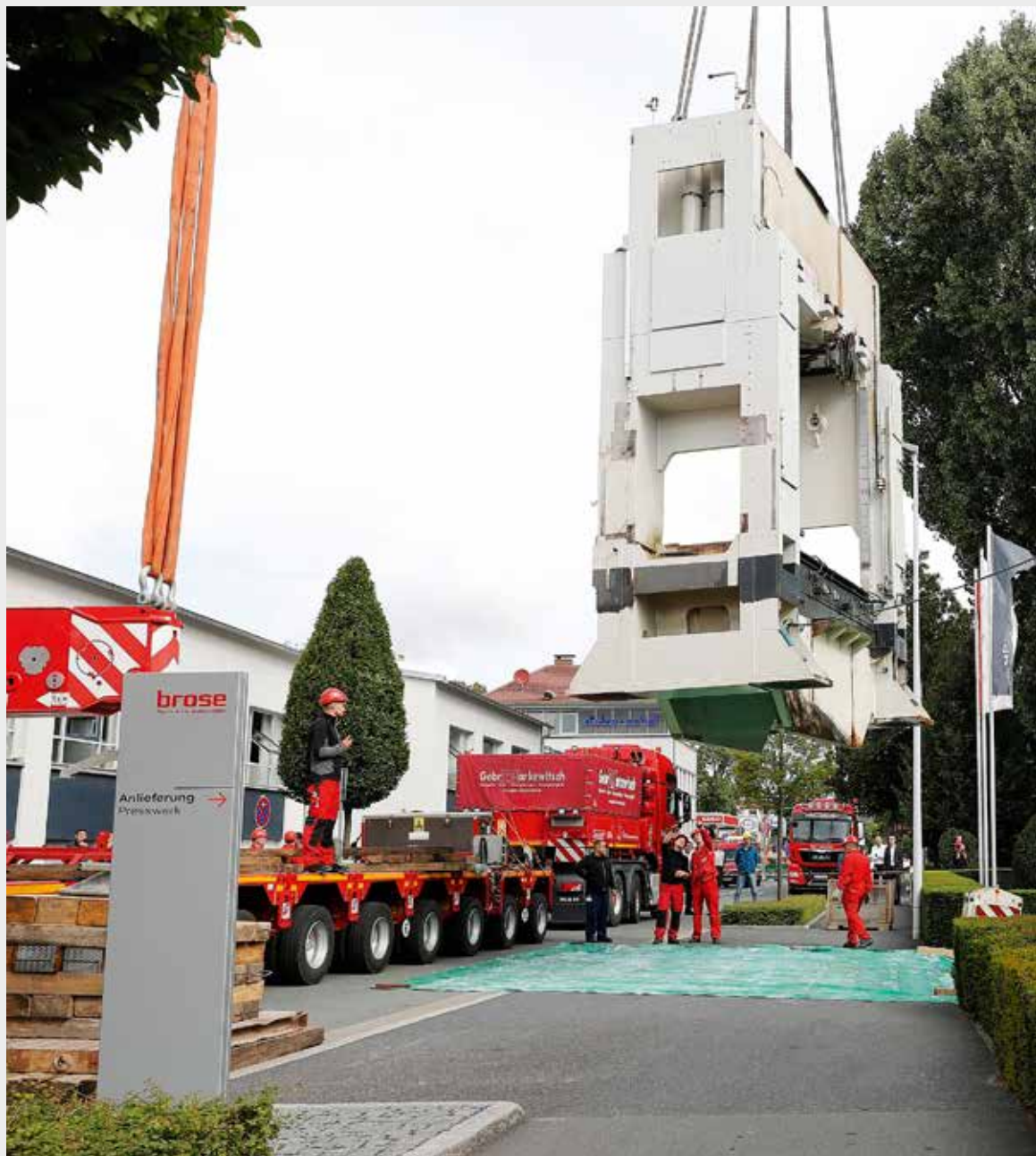
Ein 500-Tonner hob die Maschine aus dem Werksgebäude.
