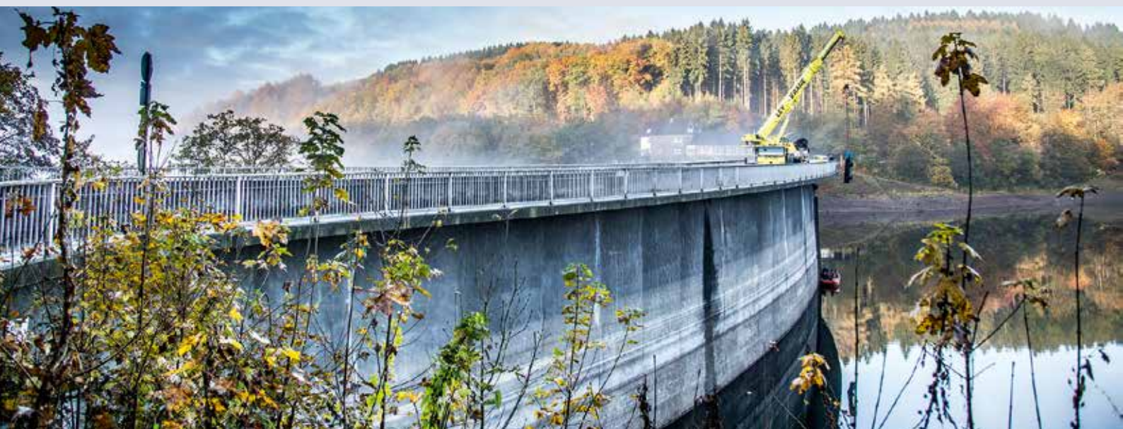
Malerische Idylle: Der LTM 1090-4.1 beim Einbau eines Sperrschiebers.
