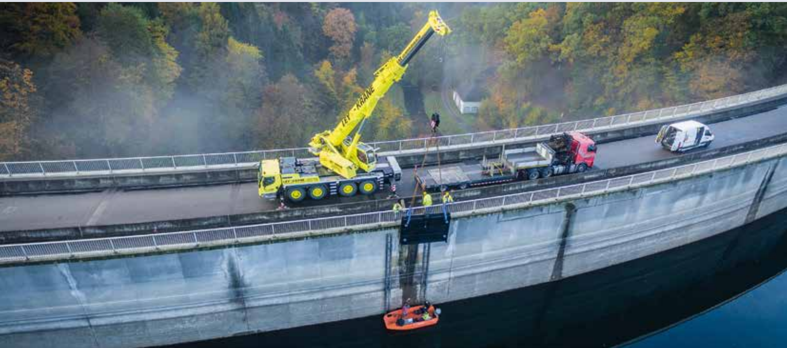
Das aufgearbeitete Rollschütz wird in die Tiefe hinabgelassen, nachdem es vom Tieflader gehoben wurde.
