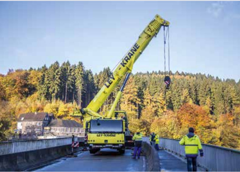
Das aufgearbeitete Rollschütz wird in die Tiefe hinabgelassen, nachdem es vom Tieflader gehoben wurde.
