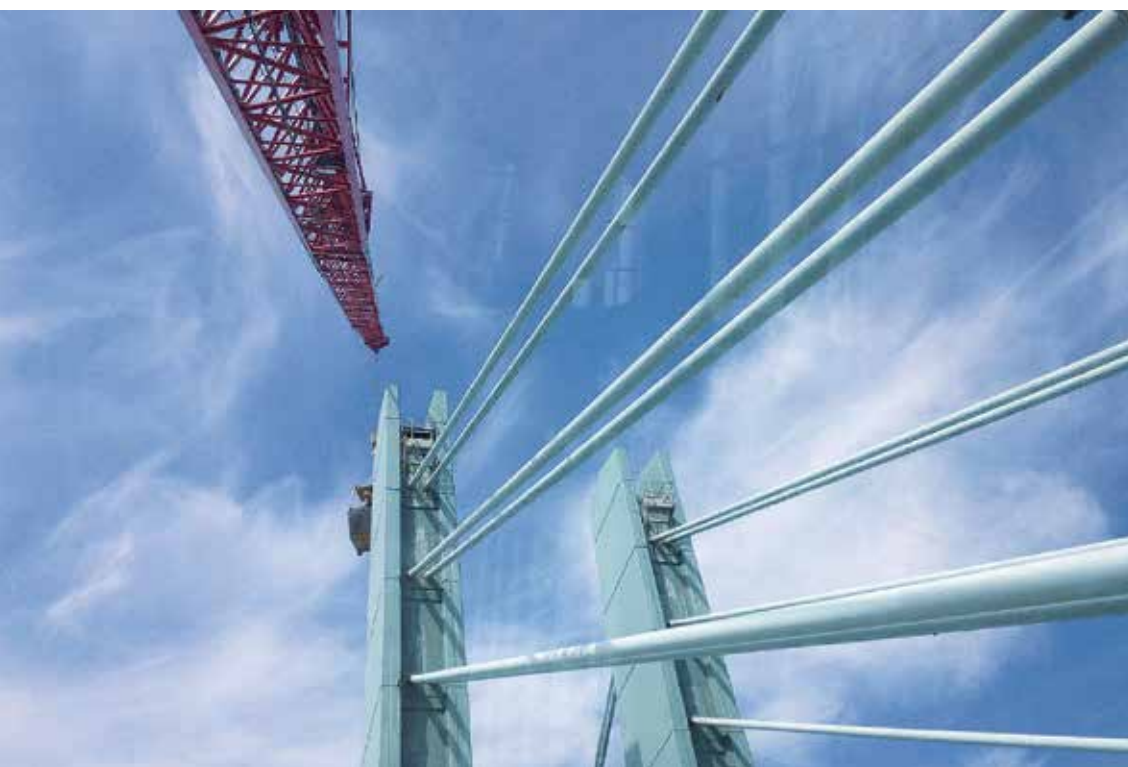
Für Wartungsarbeiten an den Schrägseilen wurde der MK 88 Plus eingesetzt.
