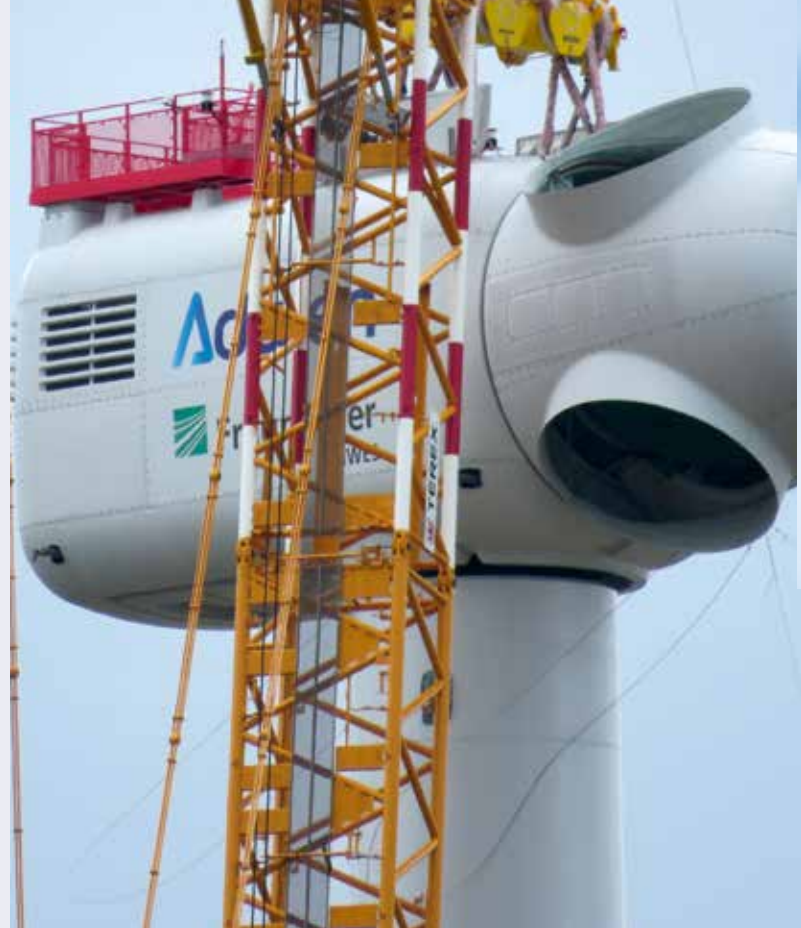
Das erste Rotorblatt wird gezogen.
