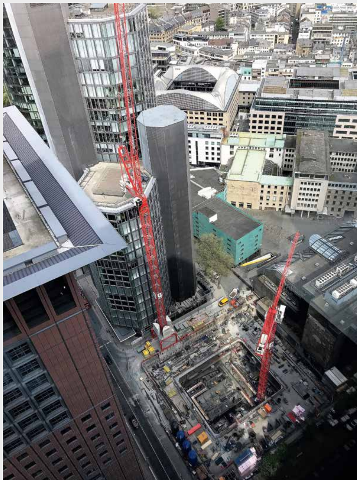
Beengte Verhältnisse auf der Baustelle zwischen der Großen Gallusstraße und der Neuen Mainzer Straße sind für die Wolff-Krane kein Problem. Der Omniturm wird in unmittelbarer Nähe zum Taunusturm stehen, welcher ebenfalls mit Wolff Kranen gebaut wurde.
