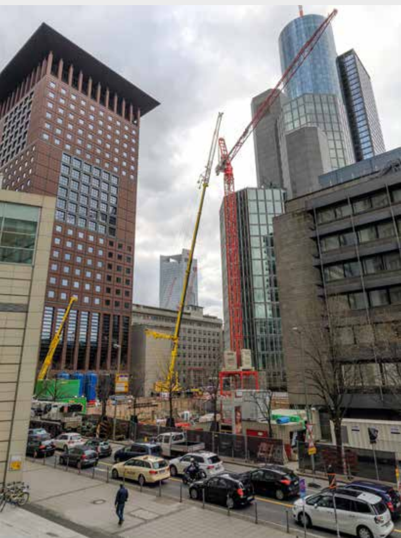
Der Wolff 355 B mit 55 m Ausleger wurde innerhalb eines Wochenendes auf eine Turmhöhe von 64 m montiert und wird im Verlauf des Bauprojekts von einem zweiten Wolff 355 B unterstützt, die beide auf eine finale Turmhöhe von 184 m geklettert werden.
