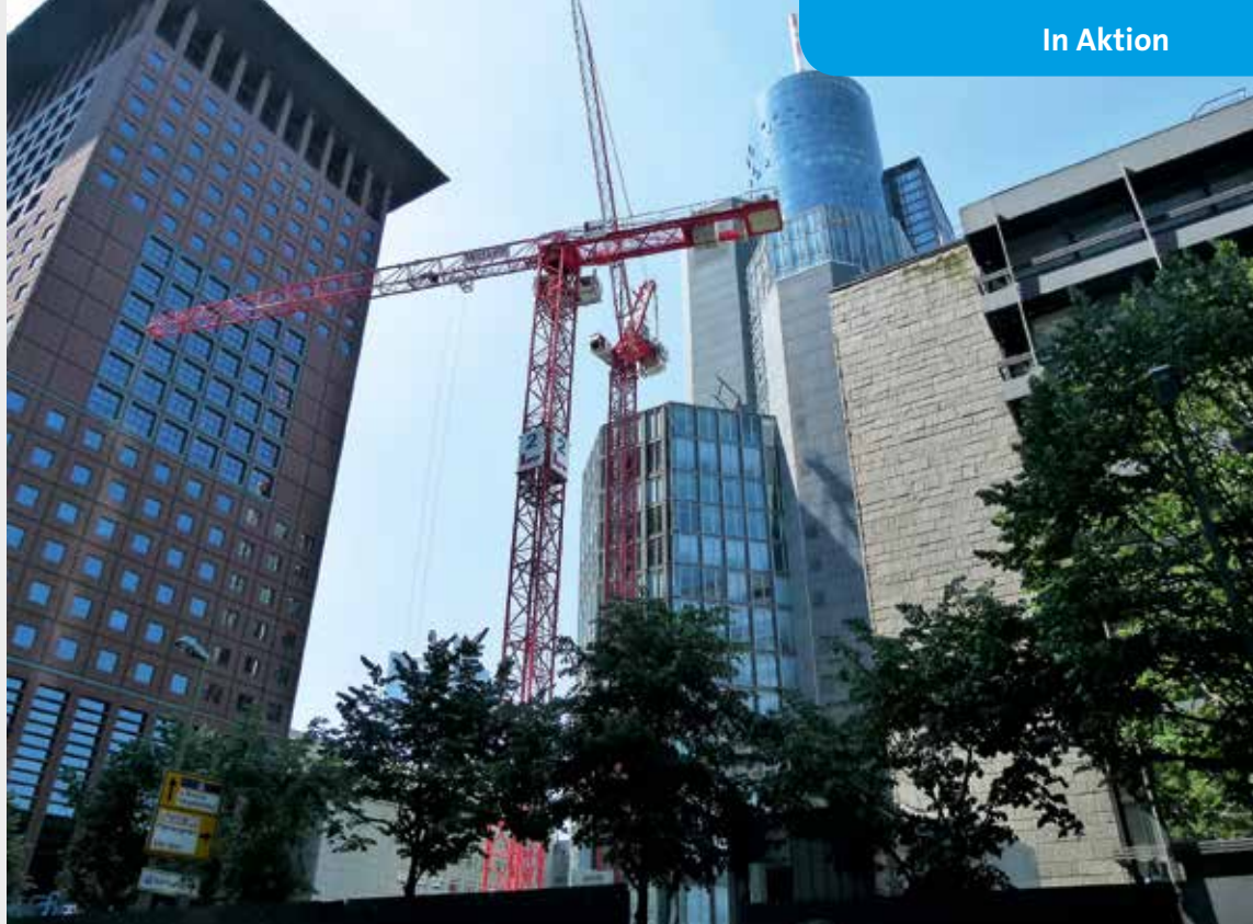
Die fast senkrechte Auslegerstellung und kurzen Gegenausleger der Wipper sowie die spitzenlose Bauweise des 6031.8 clear machen die Wölffe zur idealen Besetzung für innerstädtische Großbaustellen.
