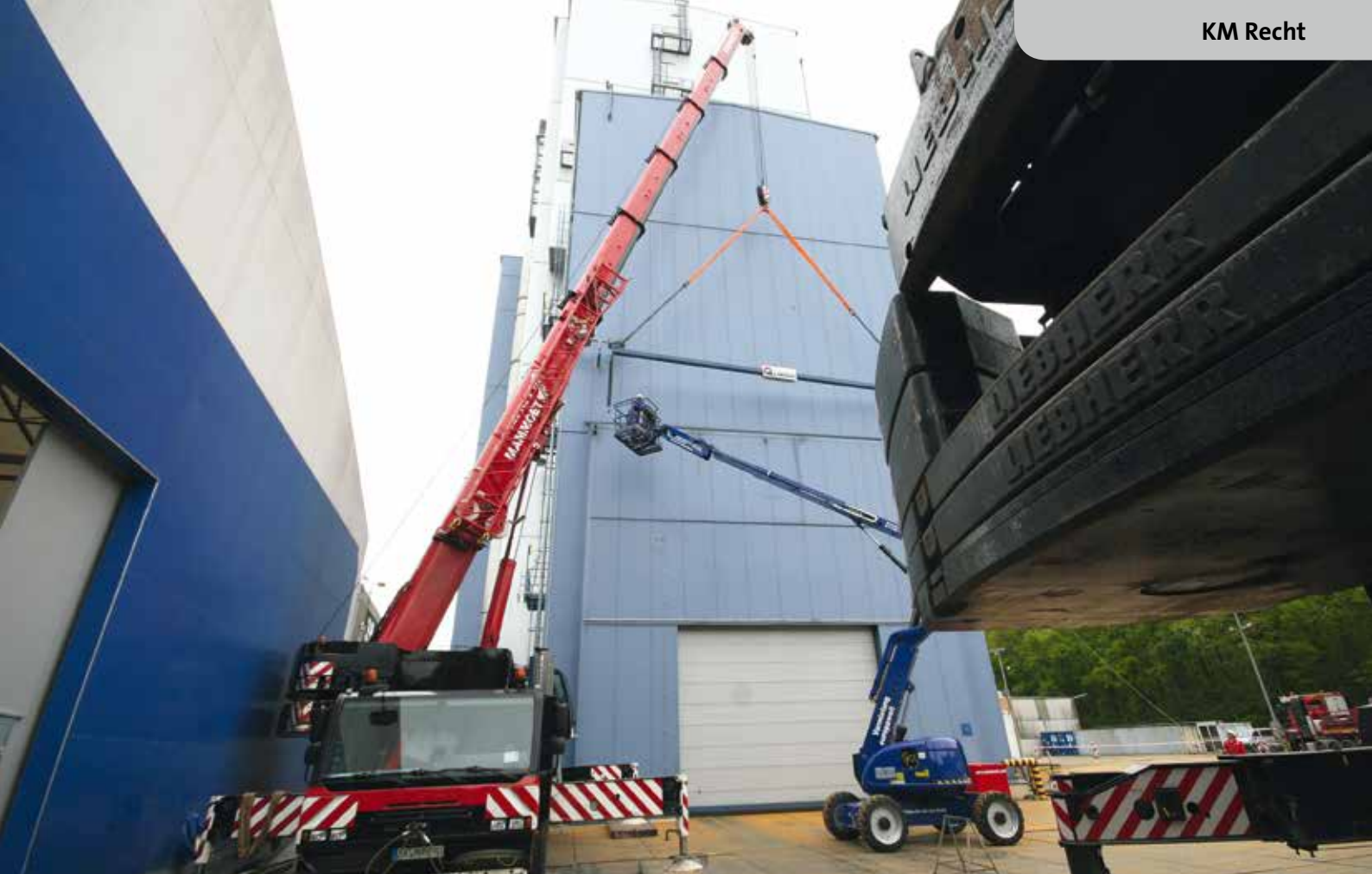
Arbeiten im Hochsicherheitsbereich: Das Tor des Forschungsreaktors in Jülich wird angeschlagen und entfernt.
