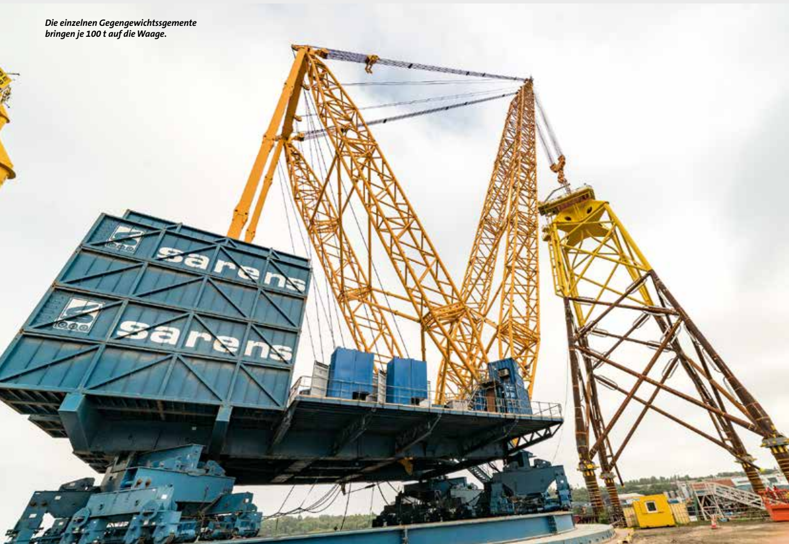
Die 397 t schweren Segmente wurden über eine Distanz von 120 m gehoben.
