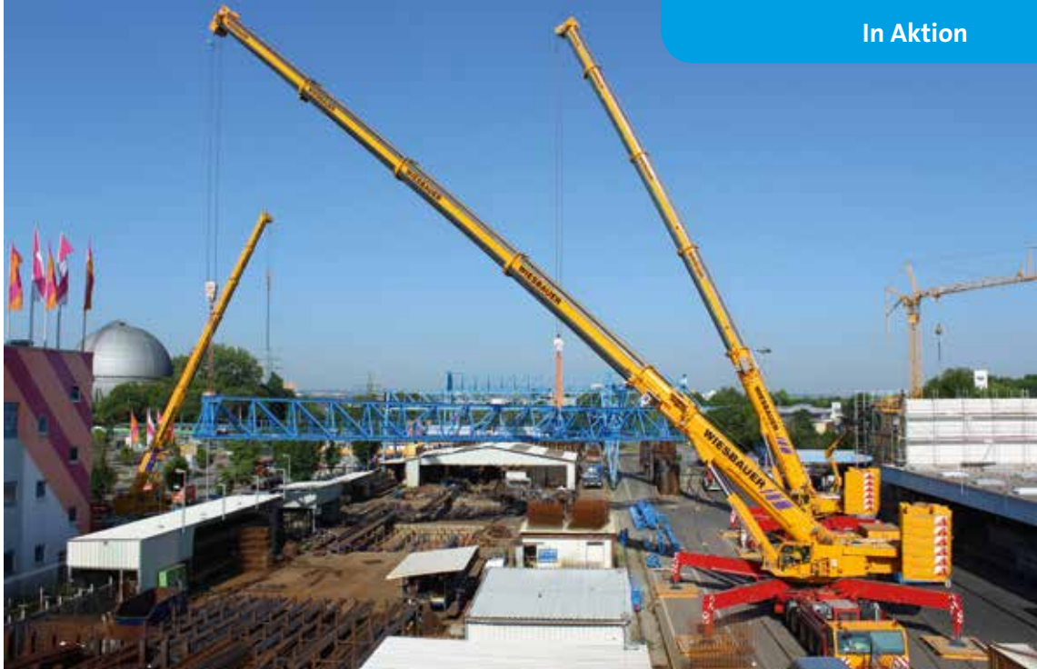
Unendliche Weiten: Am Ende betrug die Ausladung des AC 700 satte 42 m.
