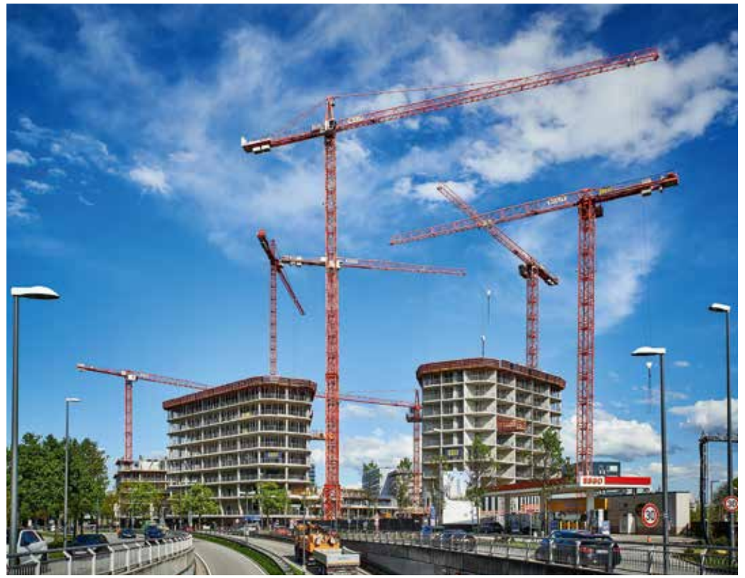
Bereits in der Planungsphase wurde berücksichtigt, dass die Obendreher freistehen müssen, da eine Abspannung an der Glasfassade des Bavaria Towers aus technischen Gründen nicht möglich gewesen wäre.
