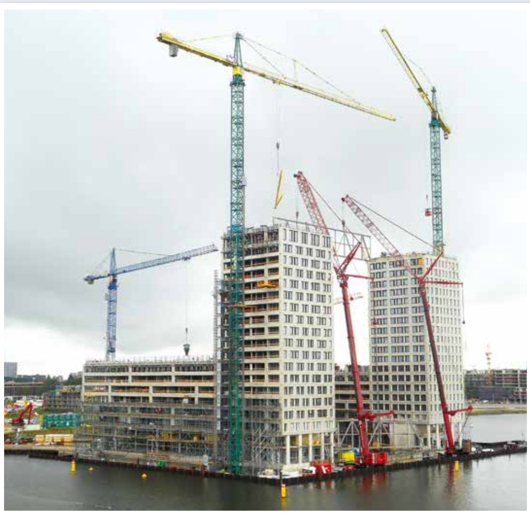
Der Pontsteiger in Amsterdam wird eines der größten und höchsten Wohngebäude von Amsterdam. Das Bild zeigt das Einheben der Verbindungsträger durch Wagenborg.
