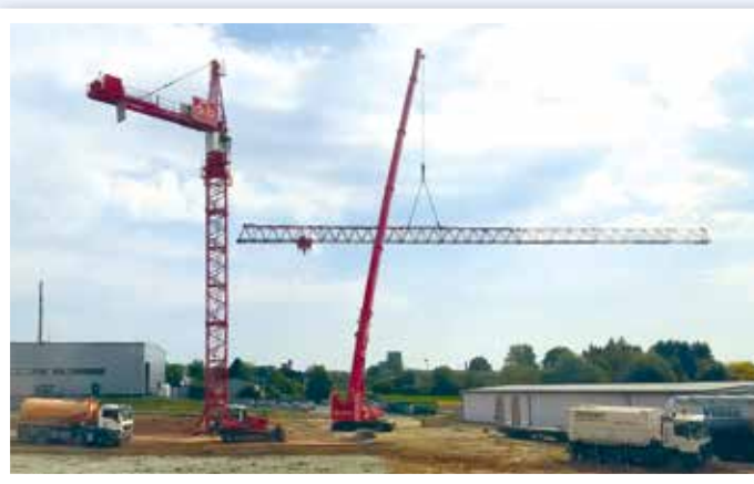
Der LTR 1100 von Dechant Bau im Ersteinsatz. Bild: KH Göring
