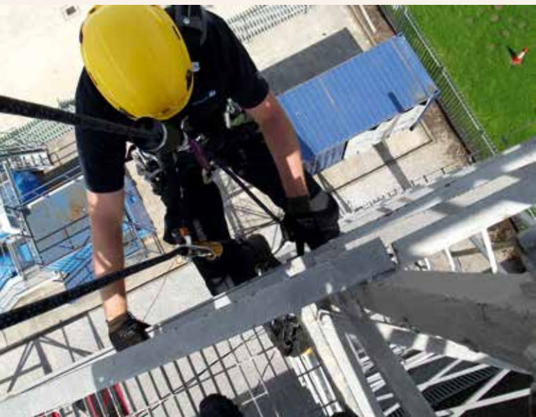
Eine persönliche Schutzausrüstung ist bei Arbeiten notwendig, bei denen kollektive Schutzmaßnahmen nicht sinnvoll sind.
