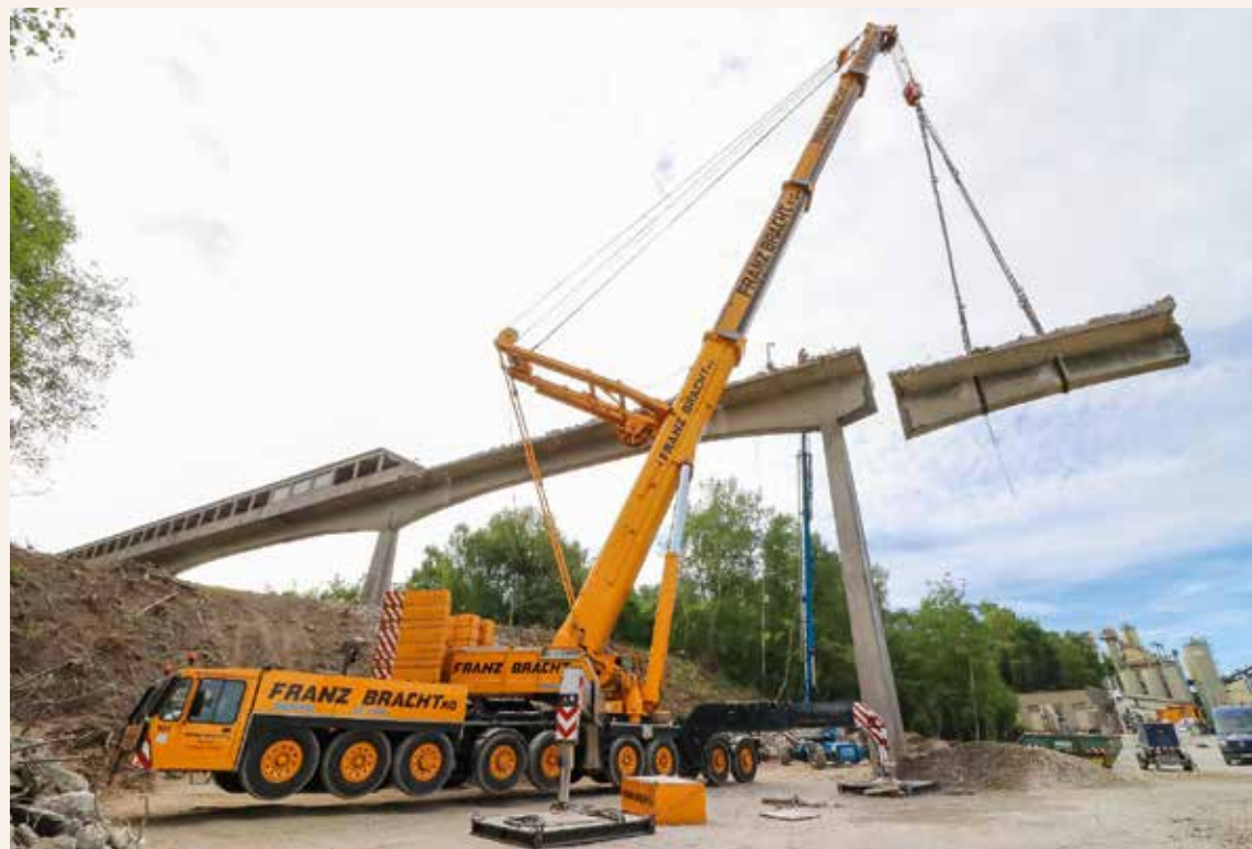
Offensichtlich: Das Montageteam oben an der Brücke muss gegen Absturz gesichert sein. Doch schon beim Rüsten des Krans sind solche Maßnahmen eigentlich ebenfalls erforderlich. Bild: Michael Bergmann
