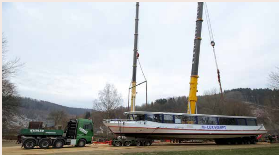
An zwei Traversen angeschlagen wurde die St. Nikolaus angehoben. 70 t bringt das Schiff auf die Waage.
