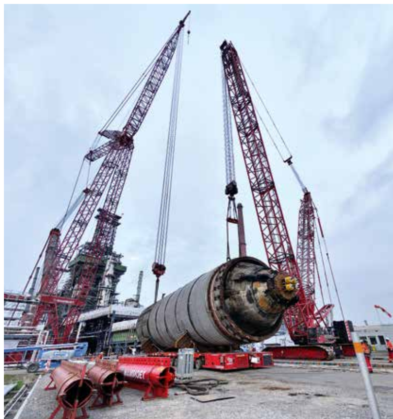
Im Tandemhub übernehmen der PT-50 und der 400 t Raupenkran CC 2400 das Ablegen der alten Coke Drum auf 28 Mammoet-eigene SPMT-Achslinien für den Abtransport.
