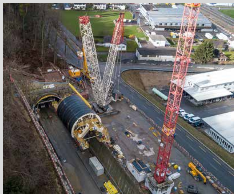
Der Raupenkran wurde einige Meter an den Grubenrand gefahren und schwenkt dann die restlichen Grad bis zum Ziel.
