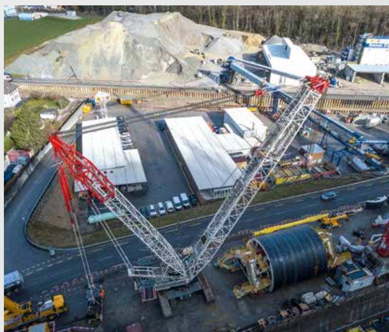
Beengte Verhältnisse: Auch auf dieser Baustelle ist Platz nicht im Überfluss vorhanden.
