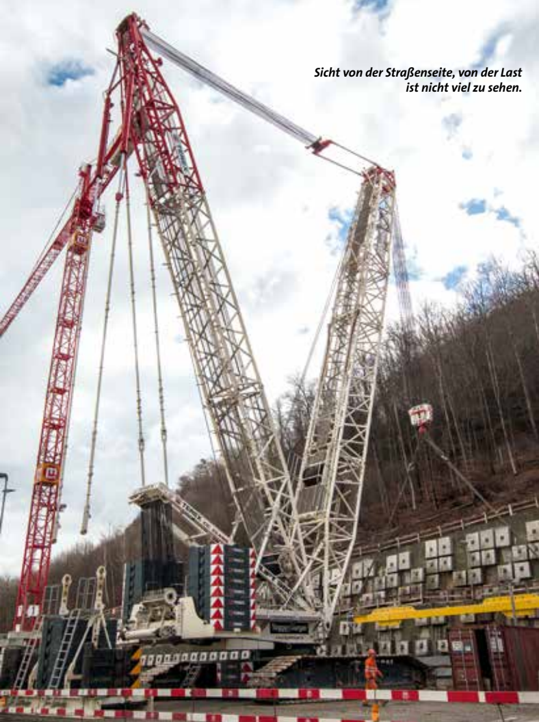
Unter Last wurde der Kran anschließend an die Kante des Tagbautunnels verfahren und der Schalwagen hinabgelassen.
