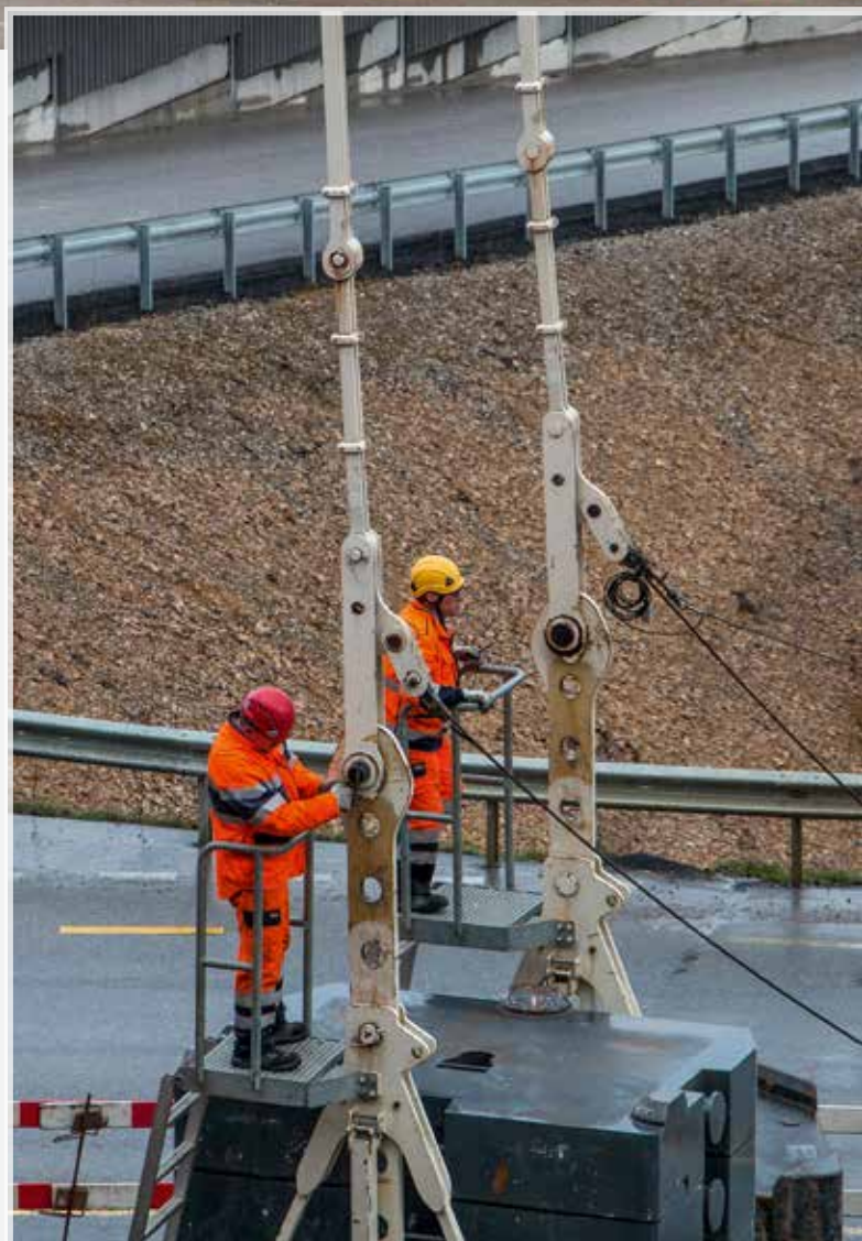
Einhängen des Superliftballasts!
