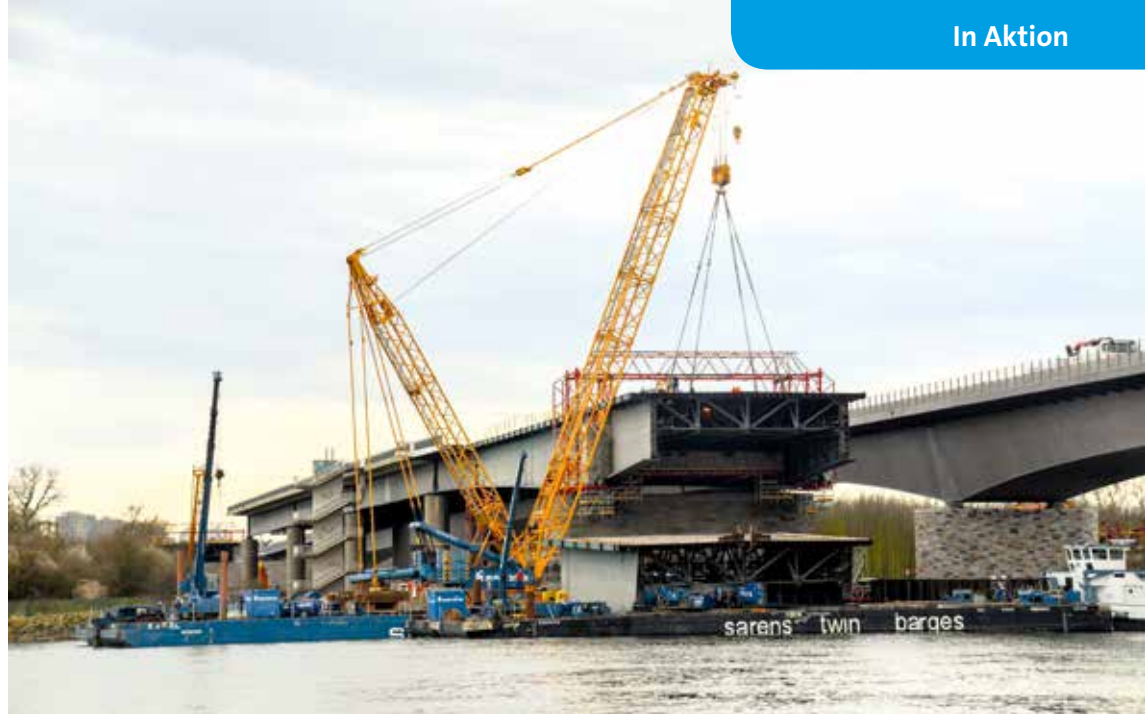
Stück für Stück der alten Schiersteiner Brücke wird demontiert.
