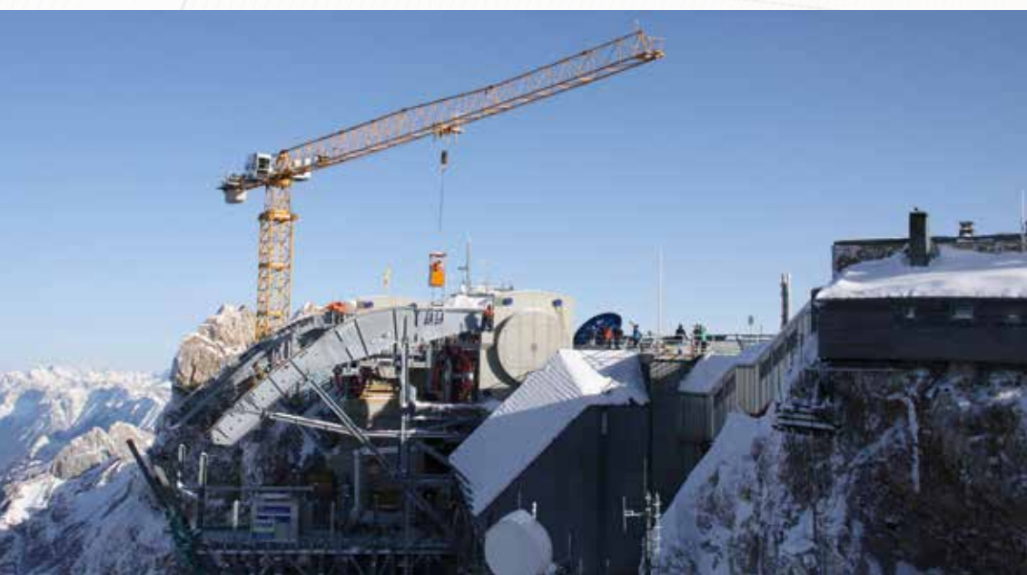
Deutschlands höchster Punkt: Auf der Zugspitze hilft ein Liebherr Flat-Top-Kran beim Bau der neuen Eibsee-Seilbahn. Er überragt das Gipfelkreuz um 13 m.
