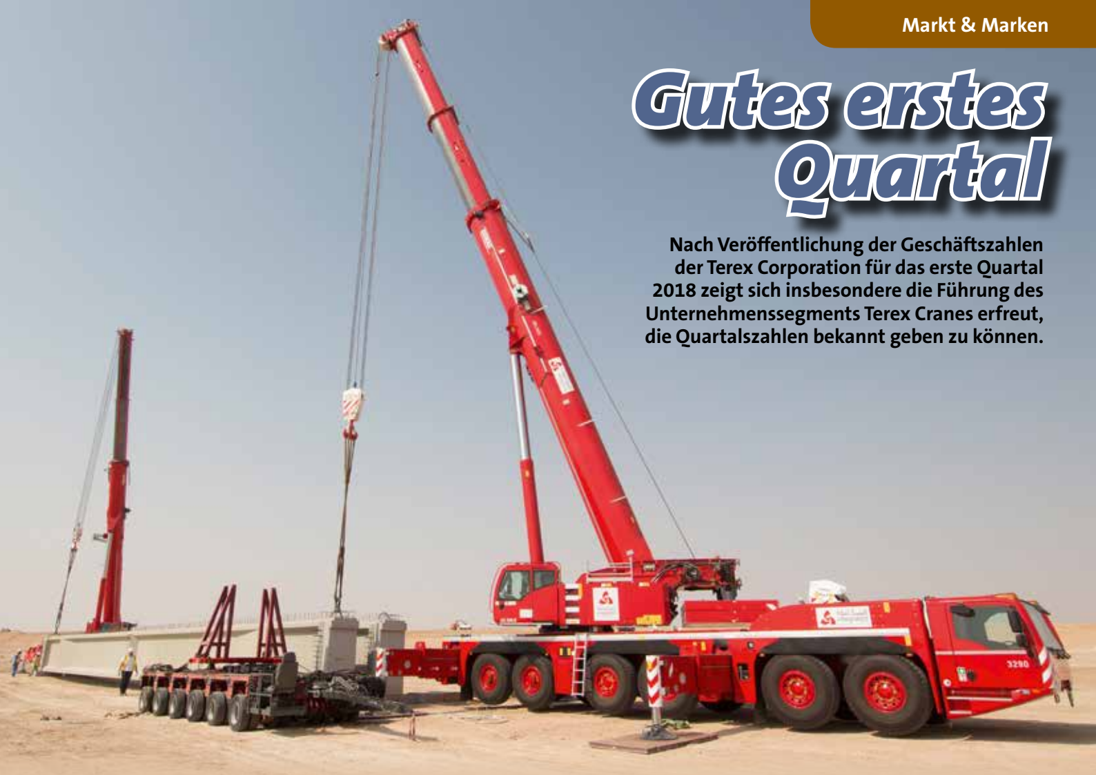
Hoffnungsträger aus Zweibrücken: Zwei AC 300-6 im Einsatz.
