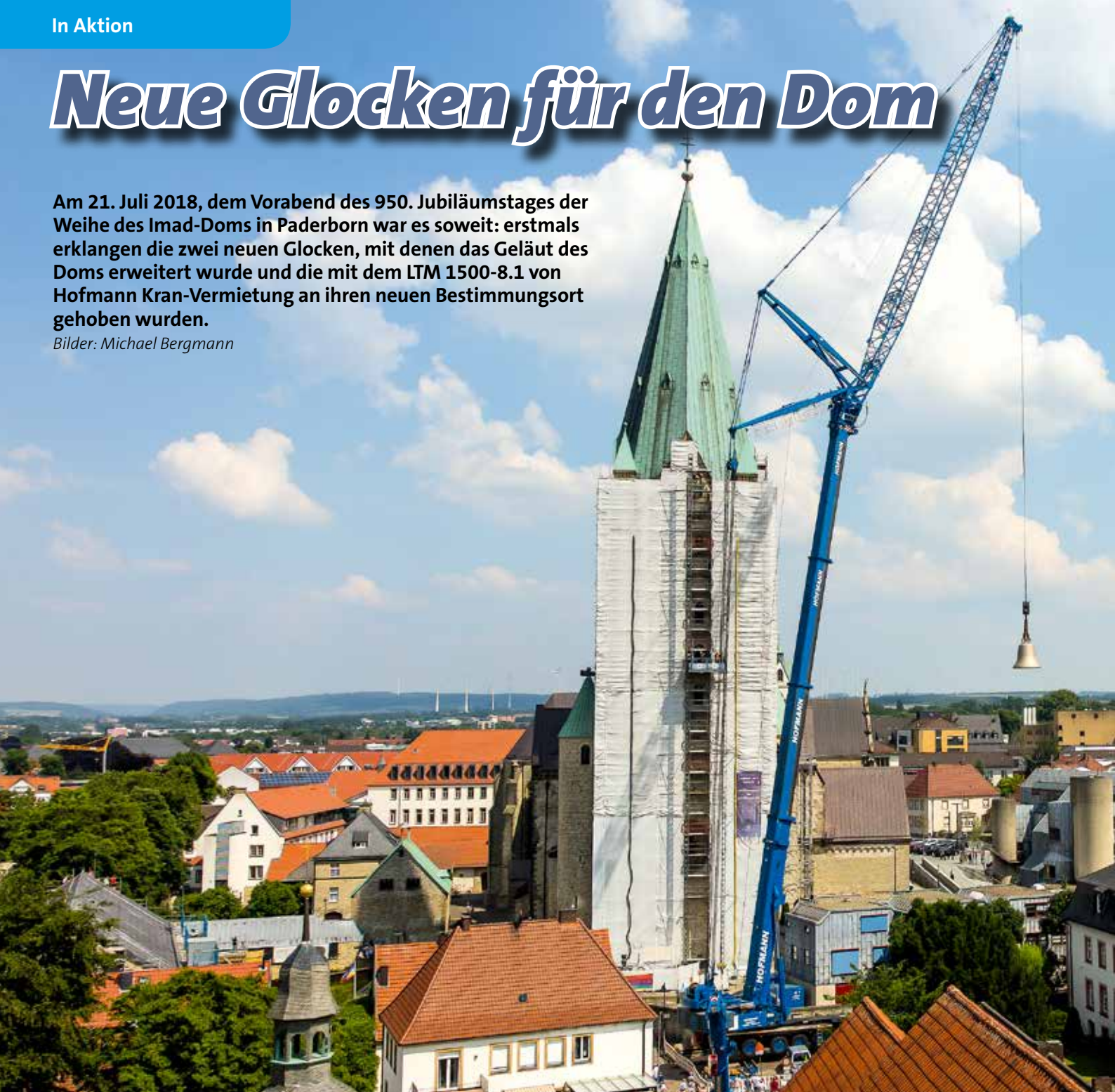
Bei einem Durchmesser von 2,70 m bringt diese Glocke ein Gewicht von 13,5 t auf die Waage.
