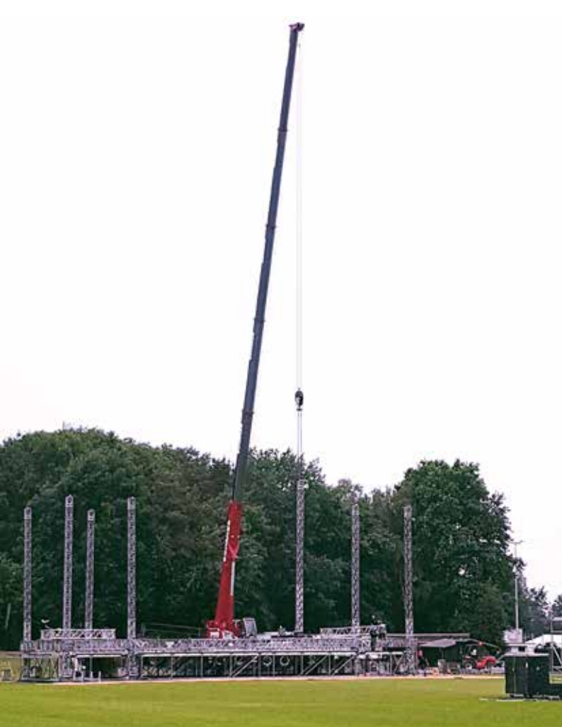
... war der LTM 1100-4.2 von Schares im Einsatz. Hier beim Aufbau der Megaforce Towerbühne TVG II am 27.5.2018.
