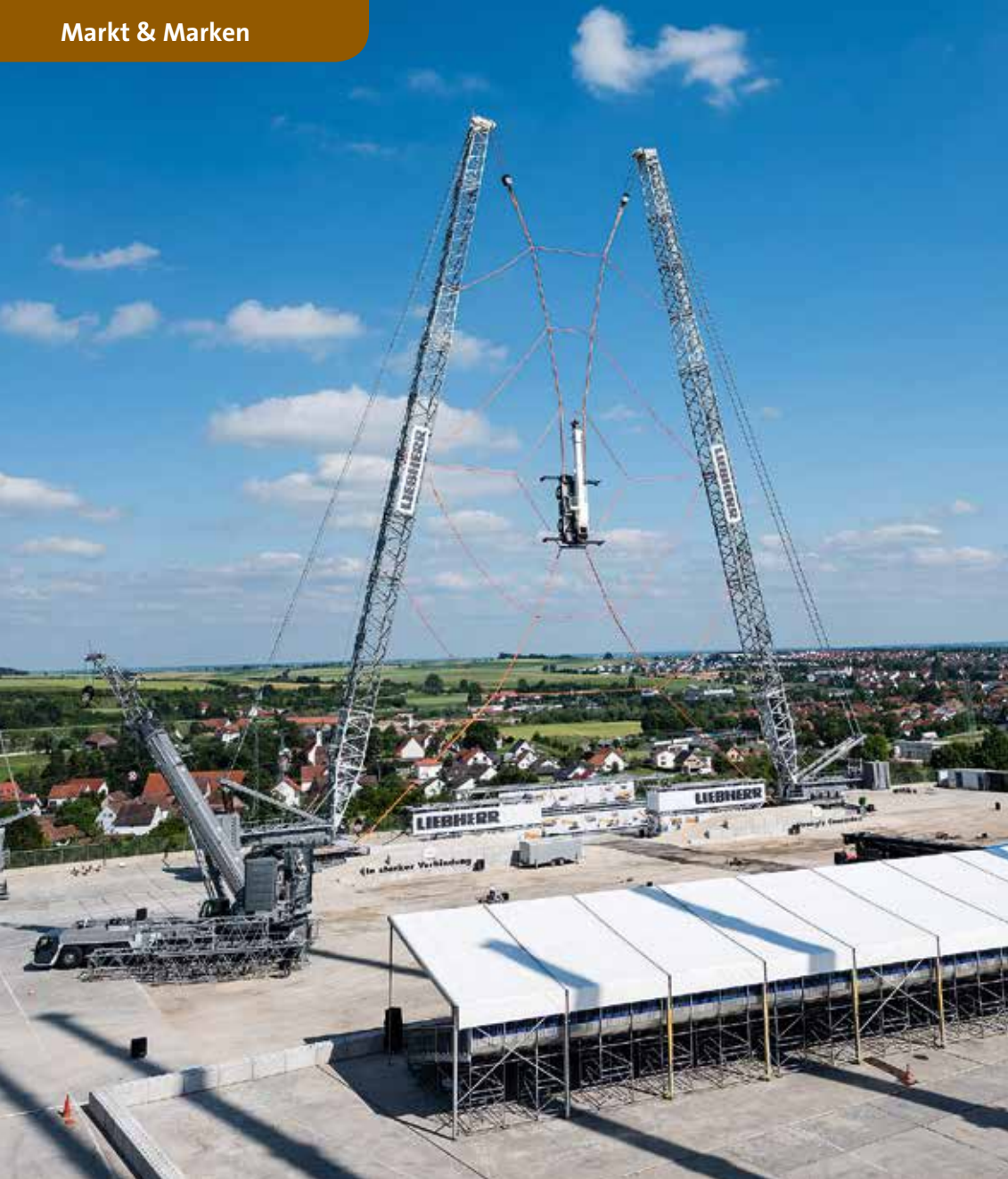
„Im Netz“: Ein Liebherr RT-Kran.
