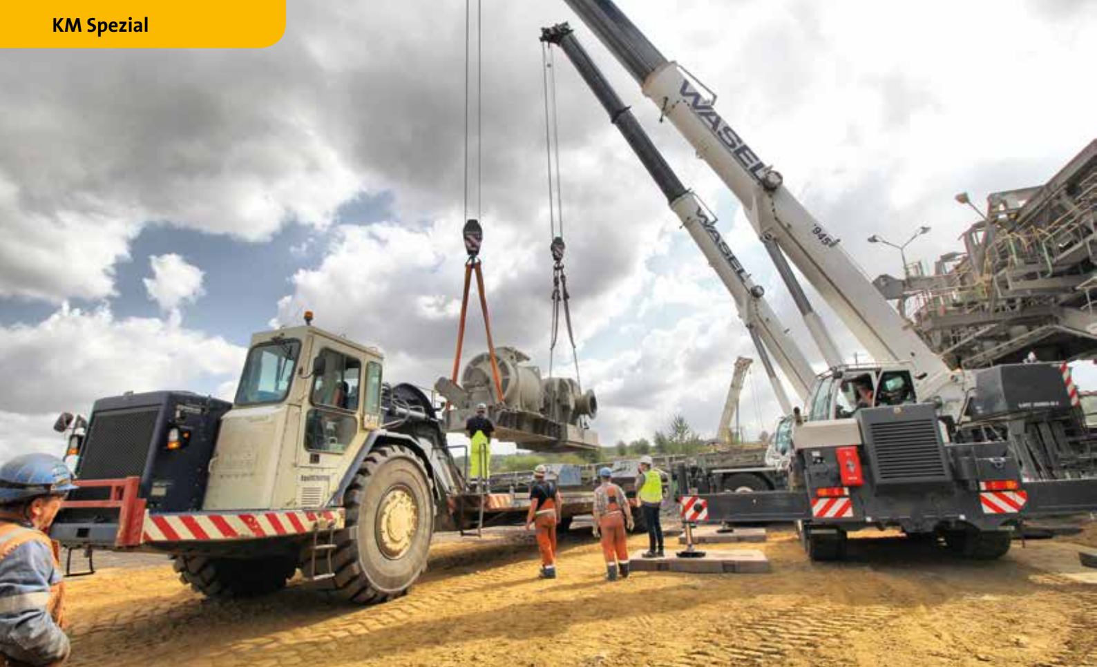
Im Tandemhub mit beiden LRT-Kranen wird die knapp 40 t schwere Getriebe-/Antriebseinheit der Bandanlage zum Abtransport auf den Tieflader gehoben.
