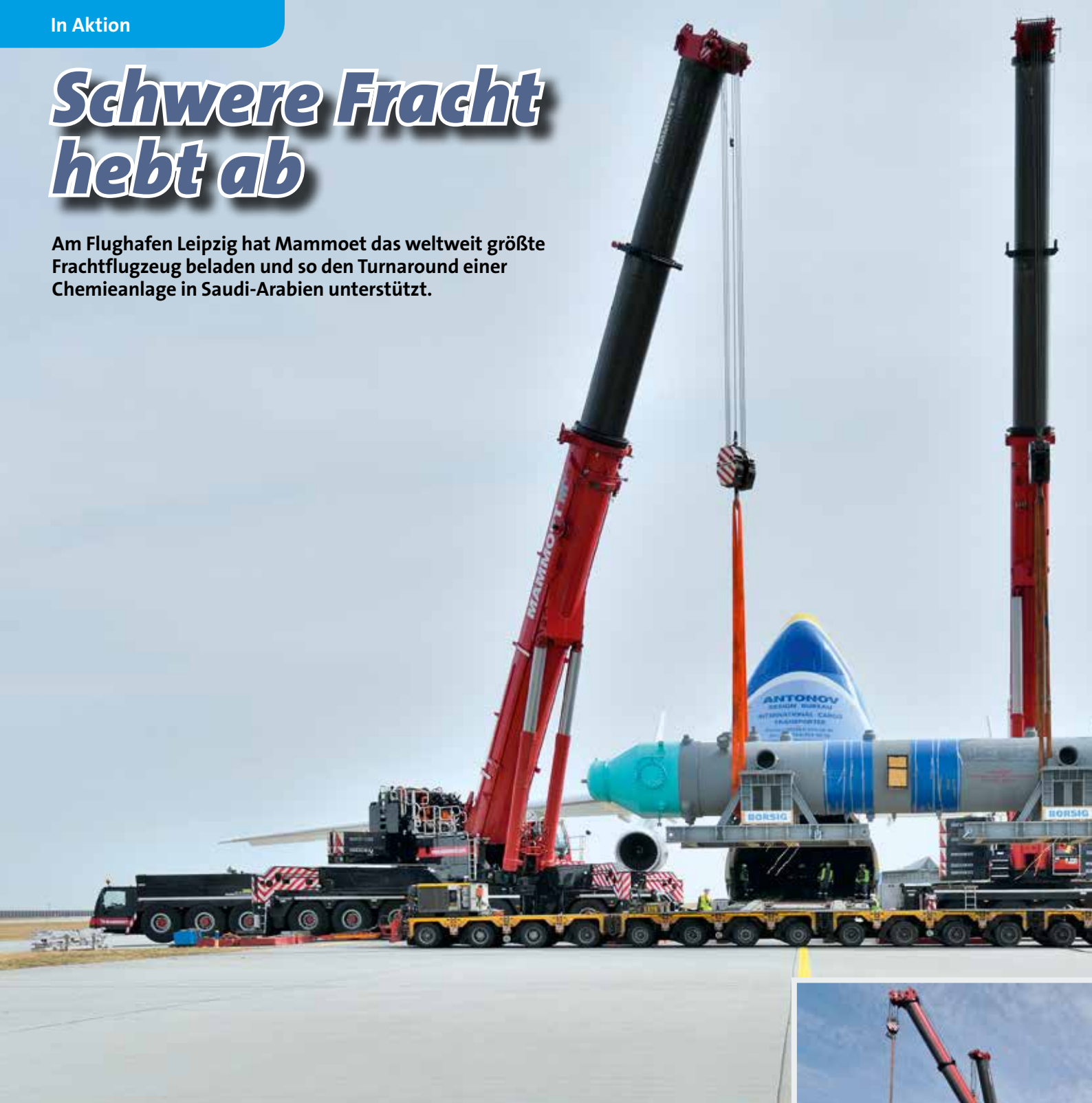
Im Tandem heben ein Liebherr LTM 1750-9.1 und ein Liebherr LTM 1400-7.1 einen der 140 t schweren und 20 m langen Kessel.
