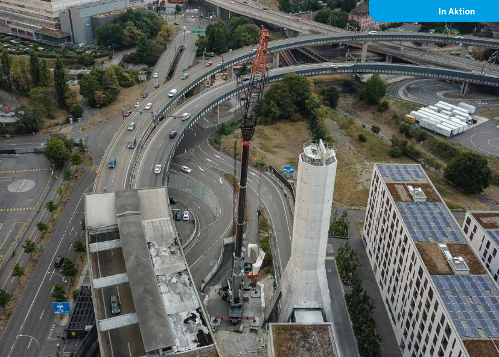
Ablassen des Kranzelements.
