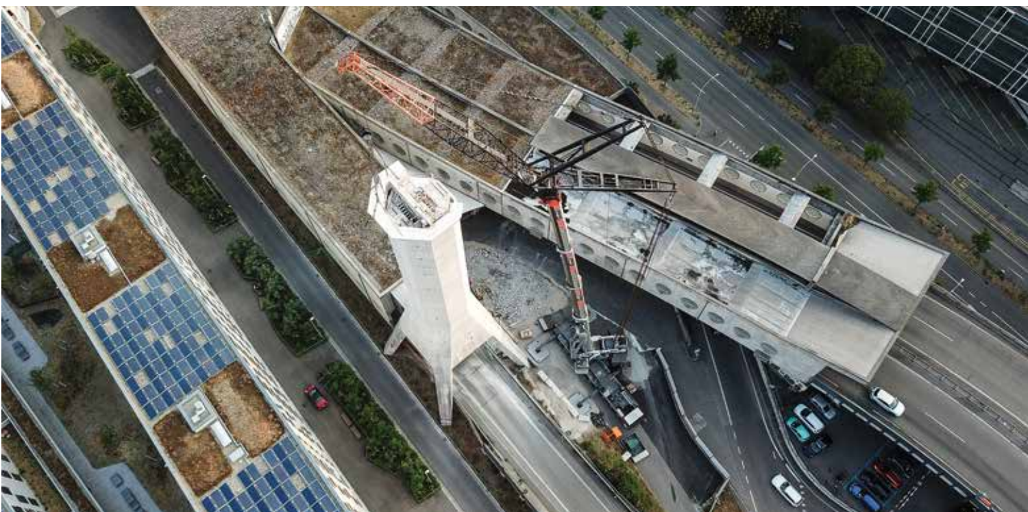
Das erste Drittel des Kaminkranzes ist bereits abgehoben worden.
