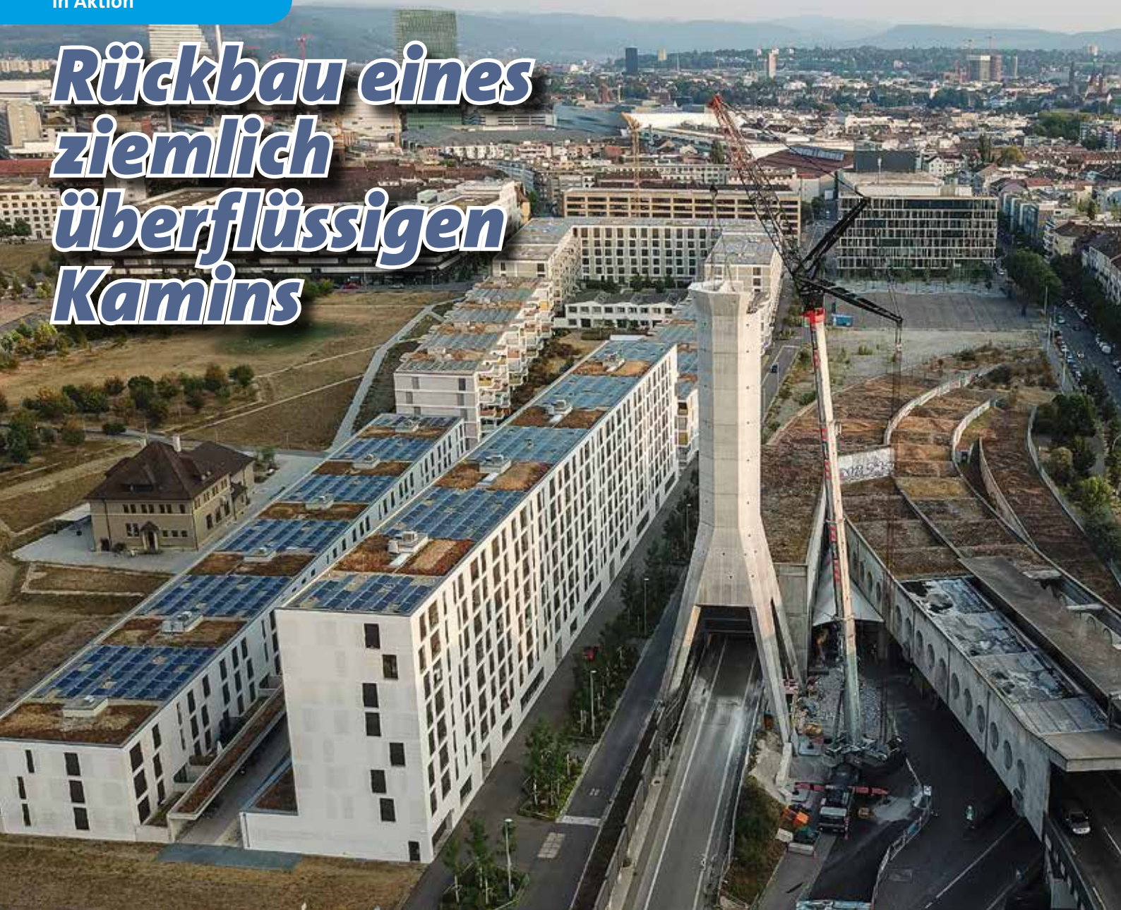
Die Baustelle von oben – mit dem Kranplatz zwischen Ein- und Ausfahrt.
