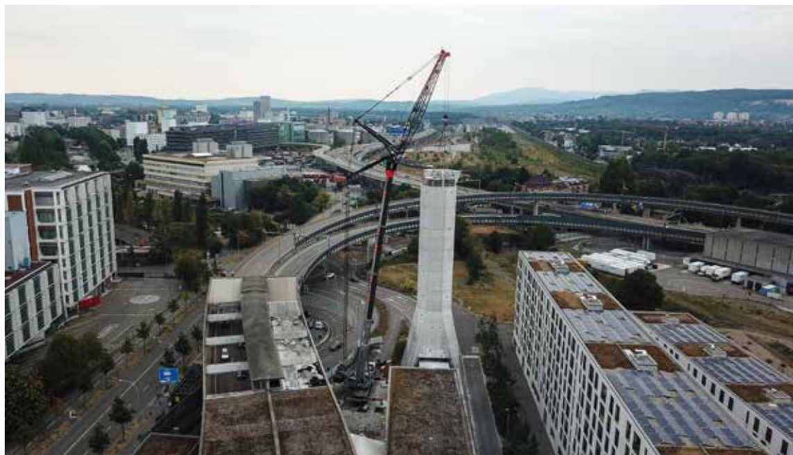
Das letzte Kroneelement wird abgehoben.
