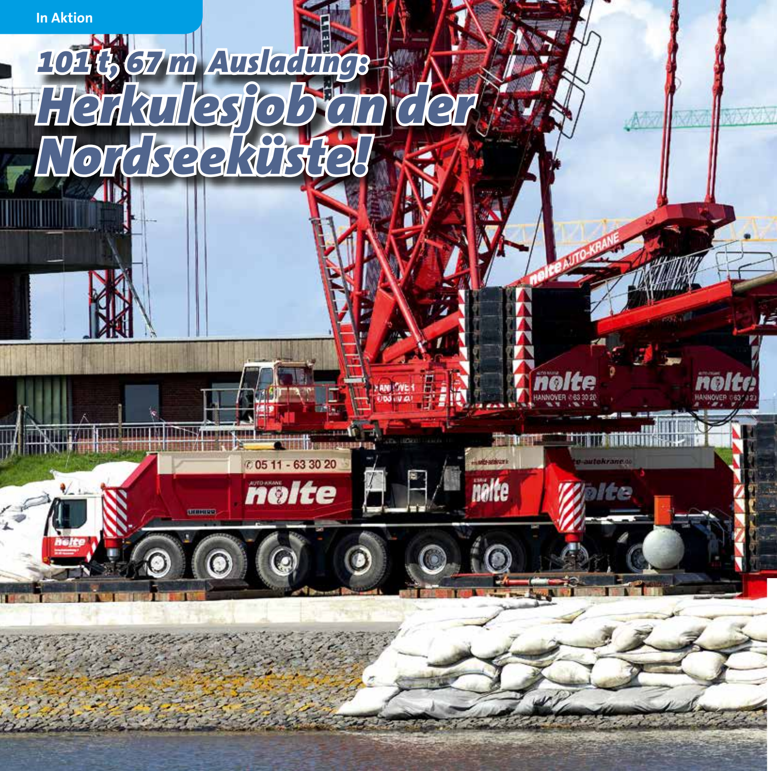
Gegengewicht: Die 350 t schwere Ballast-Palette wird an den Derrick-Ausleger gehängt. Noch einmal 220 t Stahl stapeln sich auf der Drehbühne.
