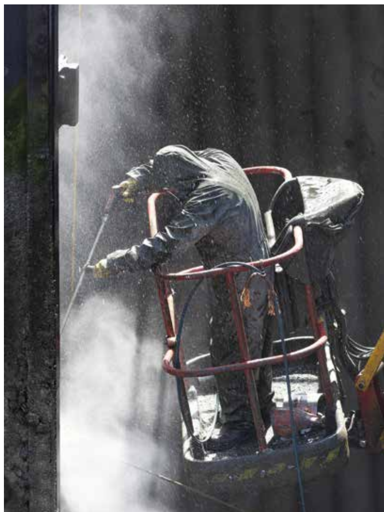
Mit Hochdruck: Tonnen von festgesetzten Austern und Miesmuscheln werden von den Schleusentoren gespritzt.
