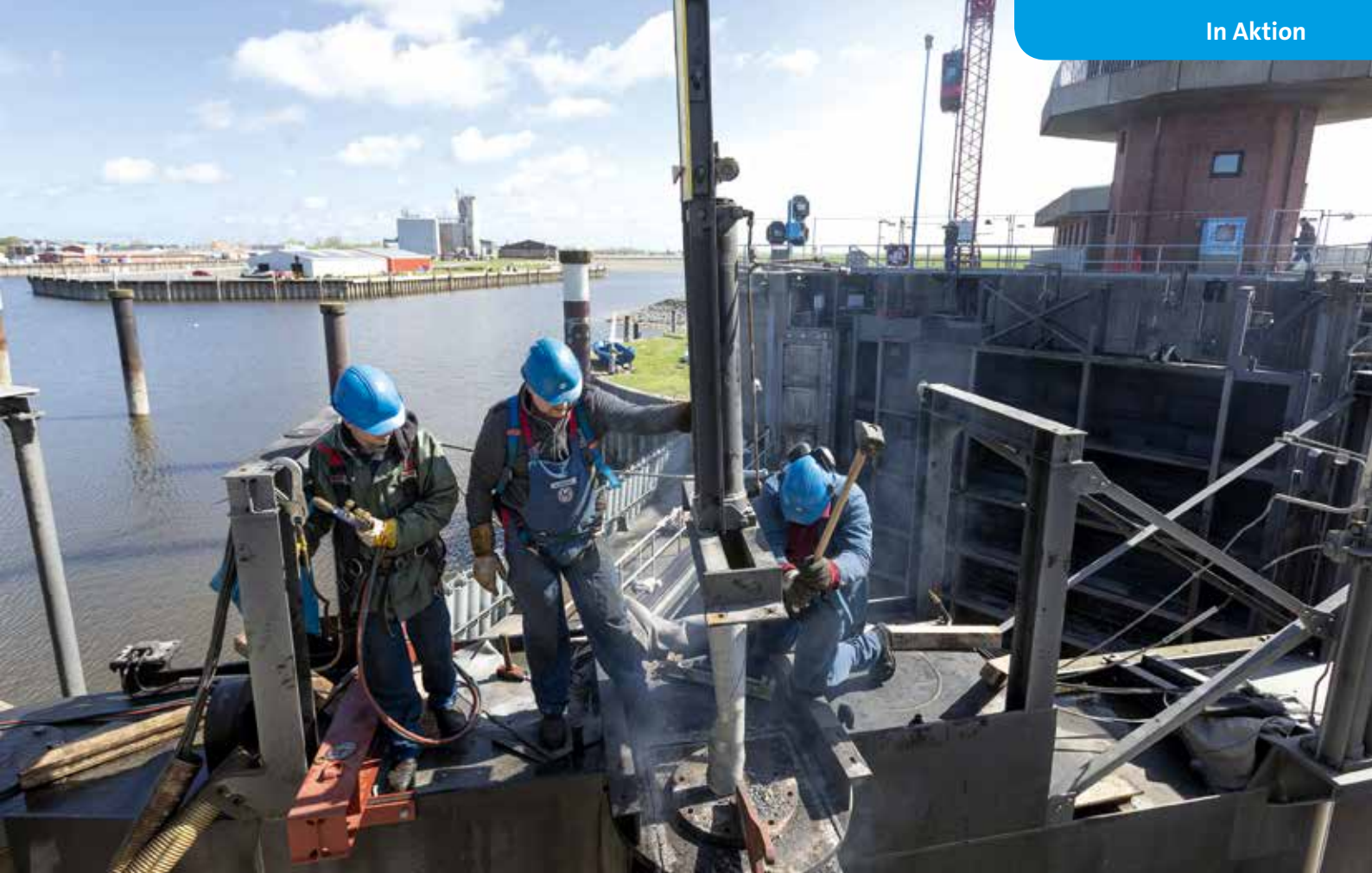
Schneidbrenner und Vorschlaghammer: Nach 35 Betriebsjahren ließ sich dieses Schleusentor nur mit großem Aufwand aus seiner Verankerung lösen.
