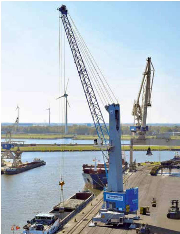
Der neue Kran bietet mit 125 t Kapazität mehr als doppelt so viel Tragkraft wie der Vorgänger-Kran.
