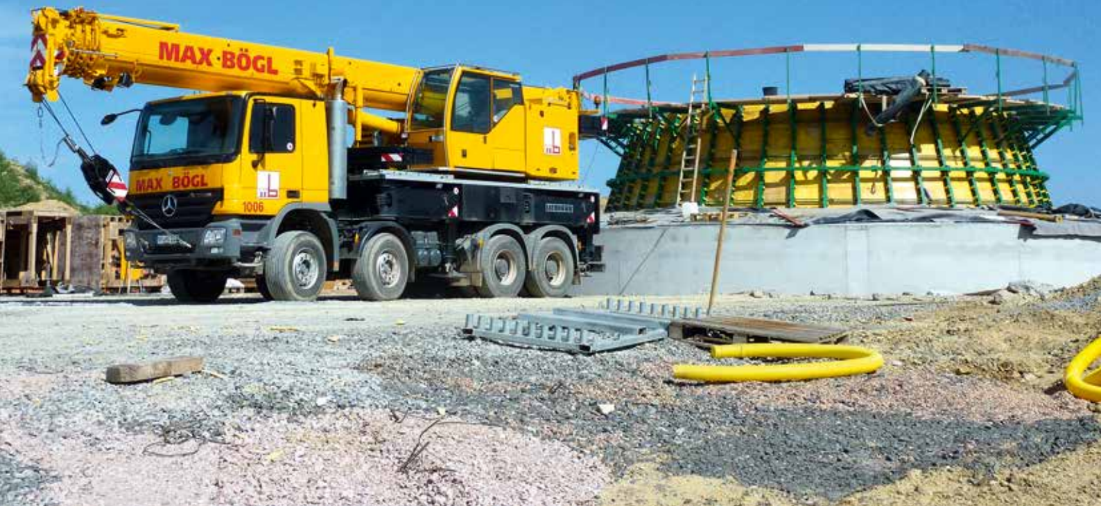
Fundamentarbeiten an einem Repowering-Projekt.
