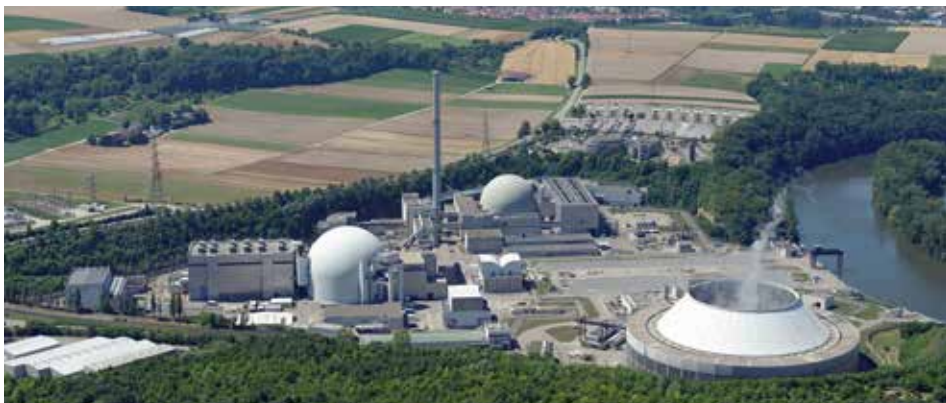
Mammoet Deutschland ist mit dem Rückbau von Großkomponenten des Kernkraftwerks Neckarwestheim I beauftragt.
