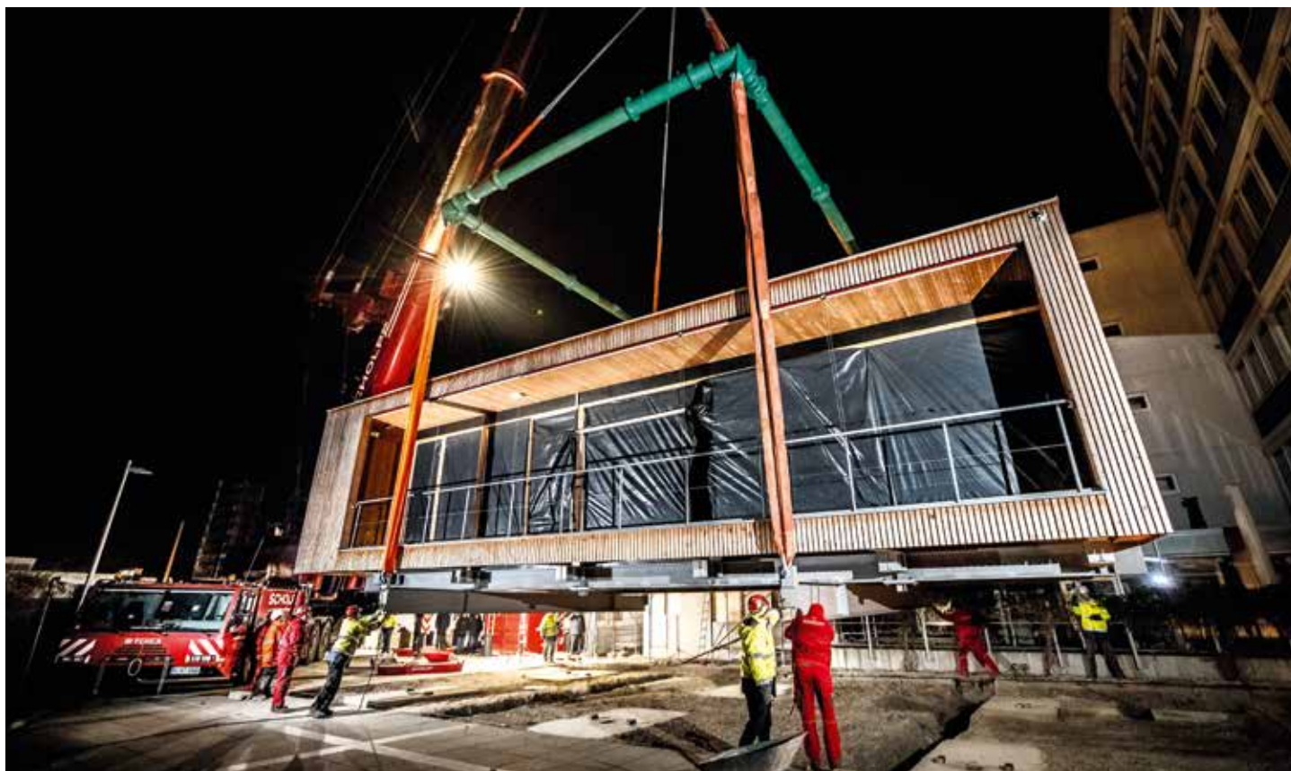
„Big Room“ wird am neuen Standort in Position gehoben.
