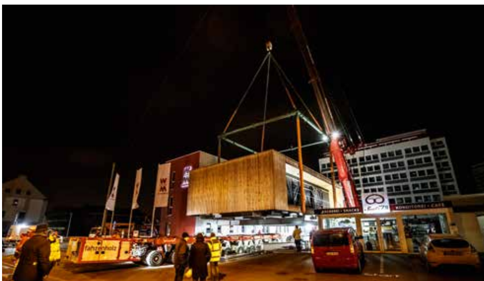
Abheben – die zweite: Scholpps S-GK 500 hebt „Big Room“ von den SPMTs.
