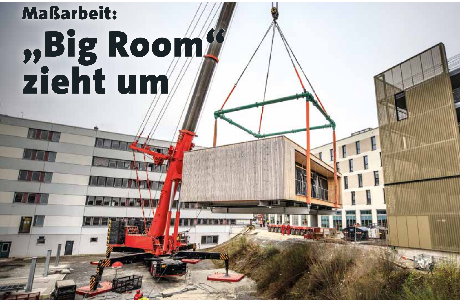
Der 700-Tonner setzt das Gebäude auf die bereitstehenden SPMT-Achslinien.
