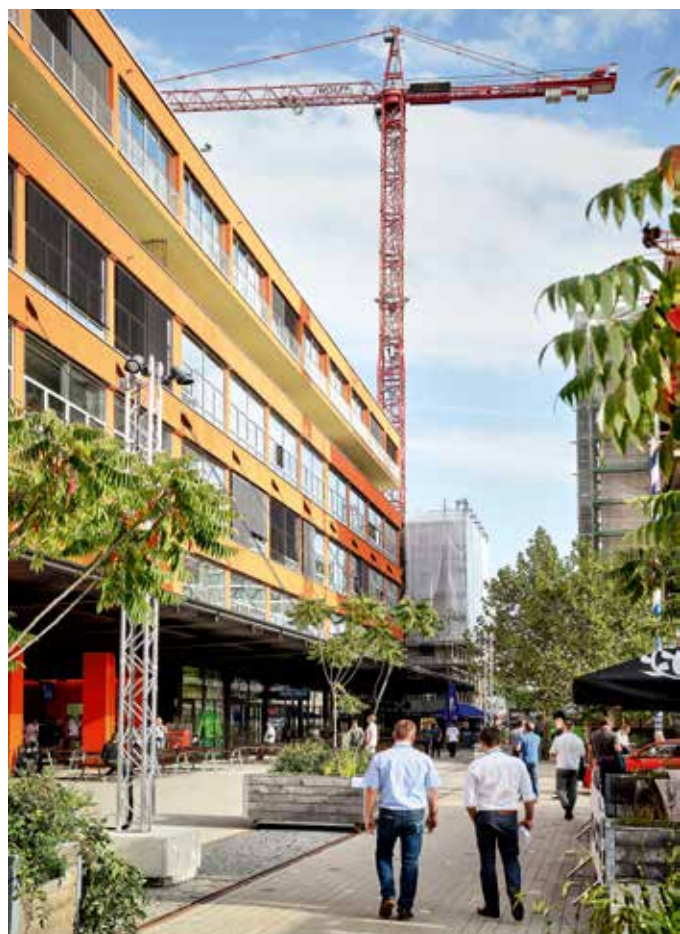
Ein spitzenloser Wolff 6023 clear sowie ein Wolff 7532 cross bauen im Auftrag von Hochtief auf dem ehemaligen Gelände des Lebensmittelherstellers Pfanni das „Werk4“.
