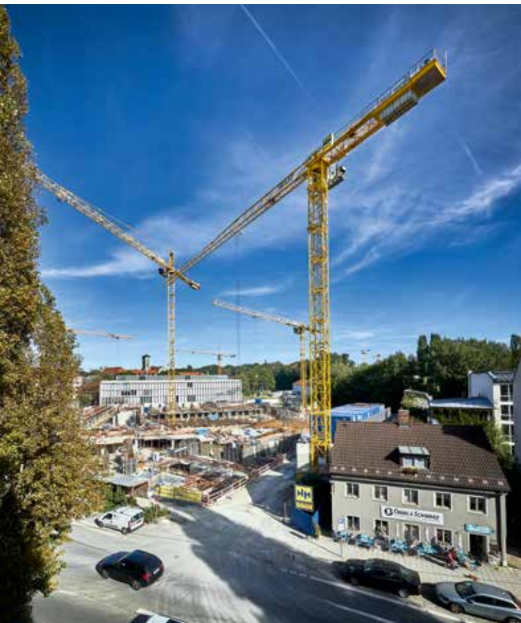
Nahе des denkmalgeschützten Eiswerks der Paulaner Brauerei entstehen 1- bis 5-Zimmer-Wohnungen ...
