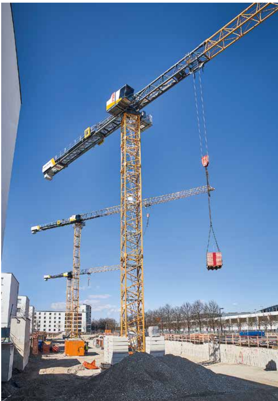
Bereits vor der bauma waren die neuen Krane im Mietpark des Münchner Standortes der BKL Baukran Logistik GmbH in Dienst gestellt worden.
