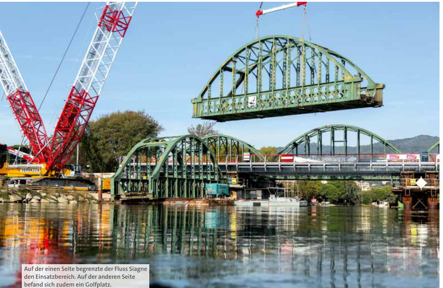
Für den Job kam der CC 3800-1 in der Konfiguration LSL mit 78 m langem Hauptausleger, Superlift-Ausrüstung und Split-Tray zum Einsatz.
