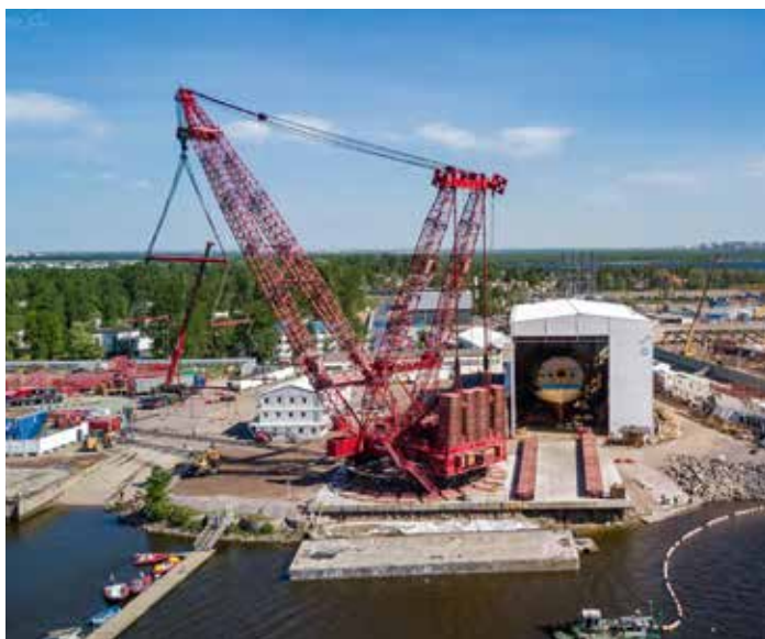
Mammoets PTC 35 kam beim Stapellauf des 600 t schweren Poltawa-Nachbaus zum Einsatz und bescherte dem Unternehmen einen weiteren ESTA-Award.
