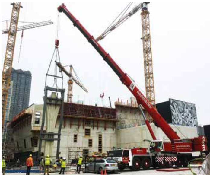
Dank des eigens entwickelten Heberahmens konnte Wagenborg Nedlift für das Bildungs- und Kulturzentrum in Den Haag die 50 Säulen, die unterschiedliche Maße und Gewichte aufwiesen, ganz nach Wunsch aufstellen.
