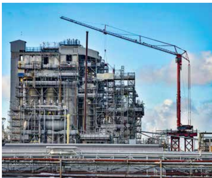
Einsatz beim Turnaround in einer Raffinerie. Hierfür erhielt Mammoet den ESTA-Award in der Kategorie Mobilkraneinsatz bis 120 t Tragkraft.
