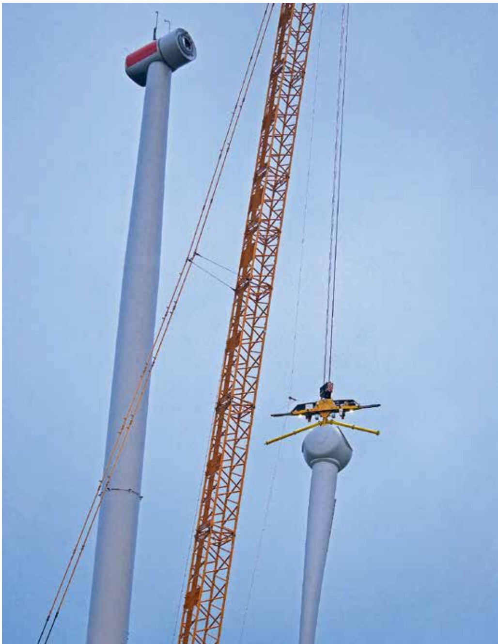
Speziell für Windkraftanlagen entwickelt: Zur EMT-Systemfamilie gehört unter anderem ein Adapter zur Aufnahme für Nabe und ein Rotorblatt.
