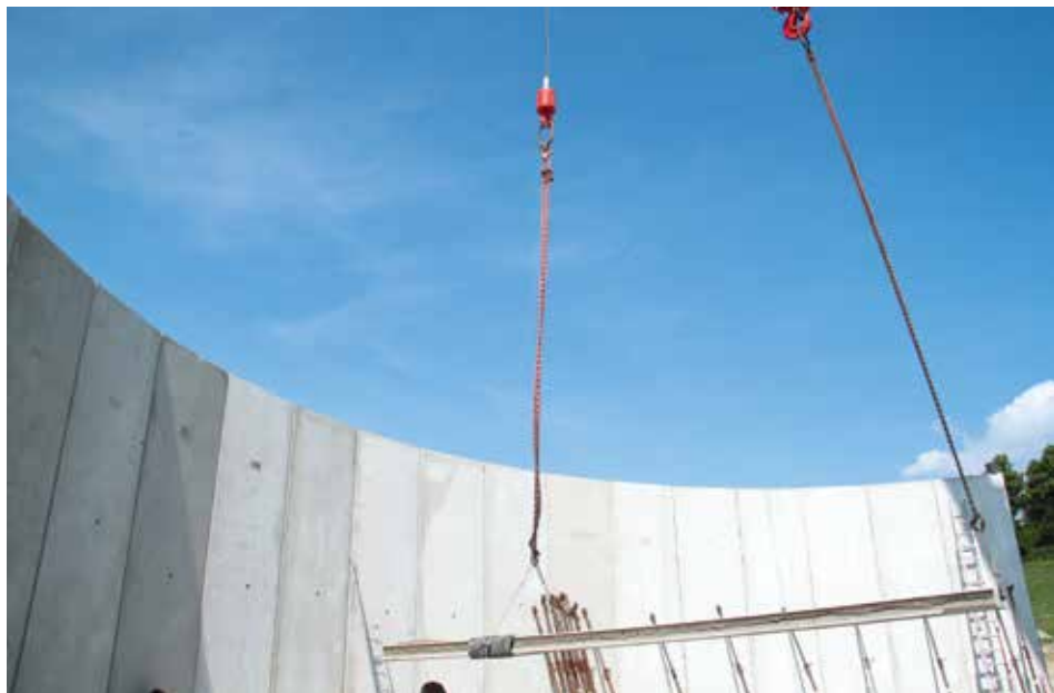
Mit den zwei Winden des ATF 100G-4 ließ sich jedes Betonteil optimal drehen und wenden.
