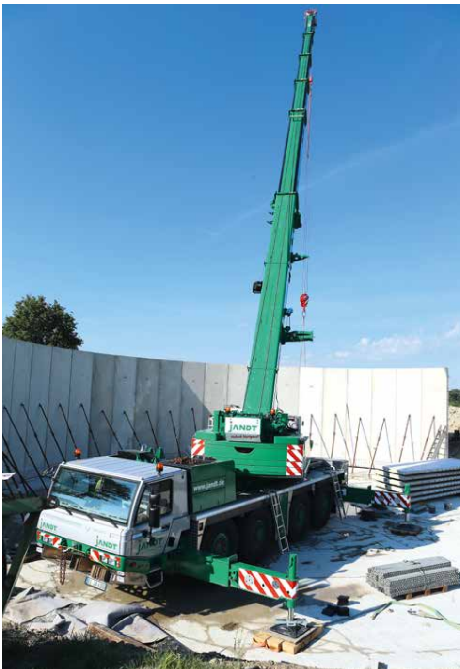
Etwa ein Drittel der Betonwände für das Güllesilo sind bereits gesetzt: Tag 1 für den ATF 100G-4 am Einsatzort in Oelde.
