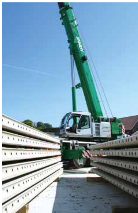
Insgesamt setzte der ATF 100G-4 an zwei Tagen 52 Betonwände. Gewicht pro Teil: 4,5 t.
