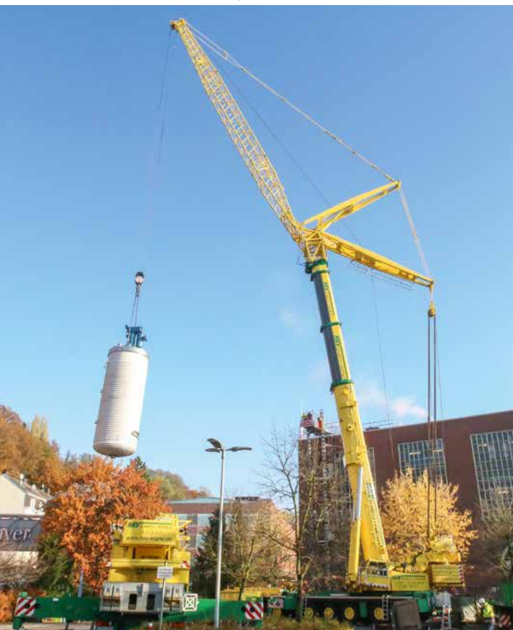
Bei einer Ausladung von circa 30 m hebt der 500-Tonner von HKV den Fermenter auf das vorbereitete Fundament.
