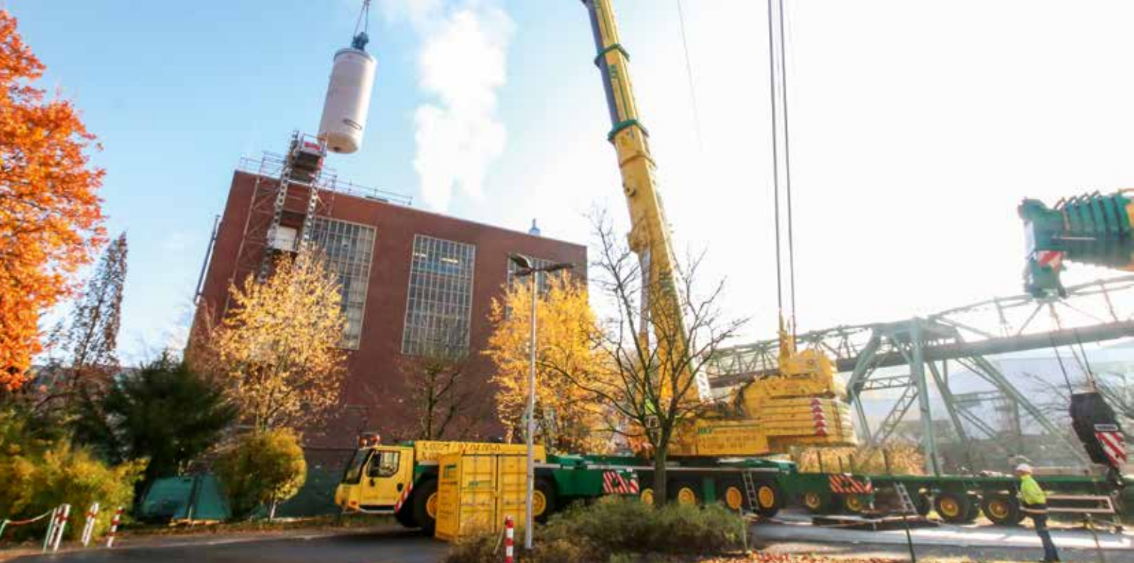
Liebherr LTM 1500-8.1 mit 35 m Wippspitze und 90 t Ballast.
