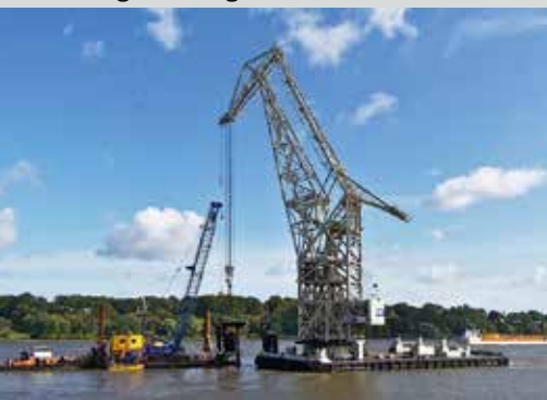
Vor Finkenwerder im Einsatz: die Schwimmkrane „HHLA III“ und „HHLA IV“.
