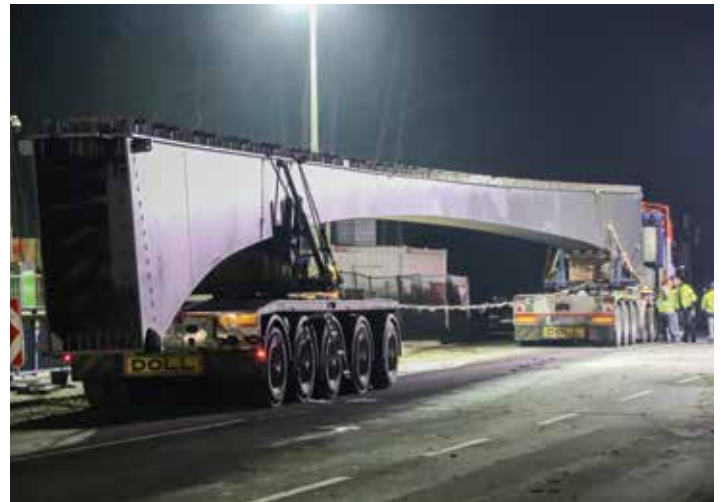
Universal Transport liefert die 50 m langen Stahlträger an der Baustelle an. Bild: Michael Bergmann
