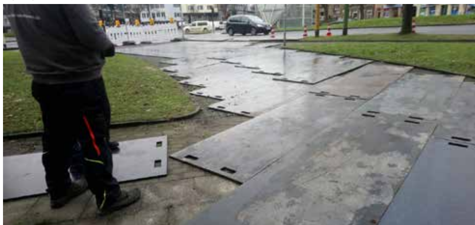
Die Fahrplatten schützen den Untergrund und sorgen für Flexibilität. Sie lassen sich auch zu größeren Flächen zusammenbauen.
