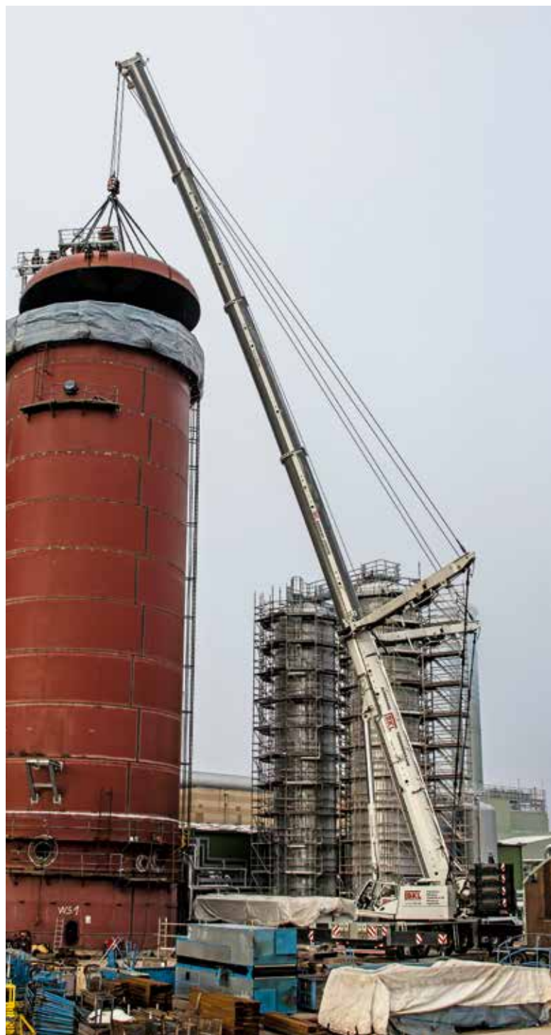
Der 400-Tonner kam mit der Hauptauslegerabspannung MegaWingLift zum Einsatz.
