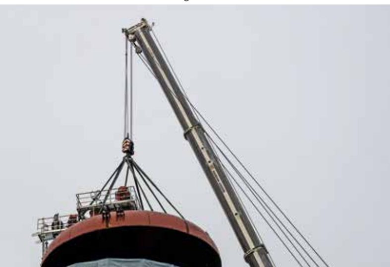
Fast geschafft! Das Bauteil wird auf den 36 m hohen Behälter aufgesetzt.
