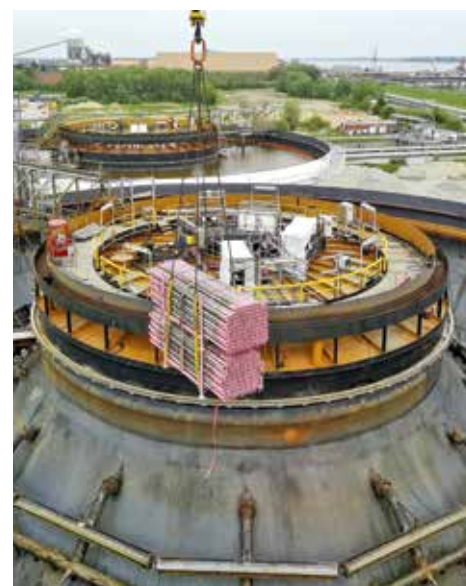
Innerhalb von vier Tages- und drei Nachtschichten hob der MK 140 insgesamt 125 t Gerüstmaterial ein.
