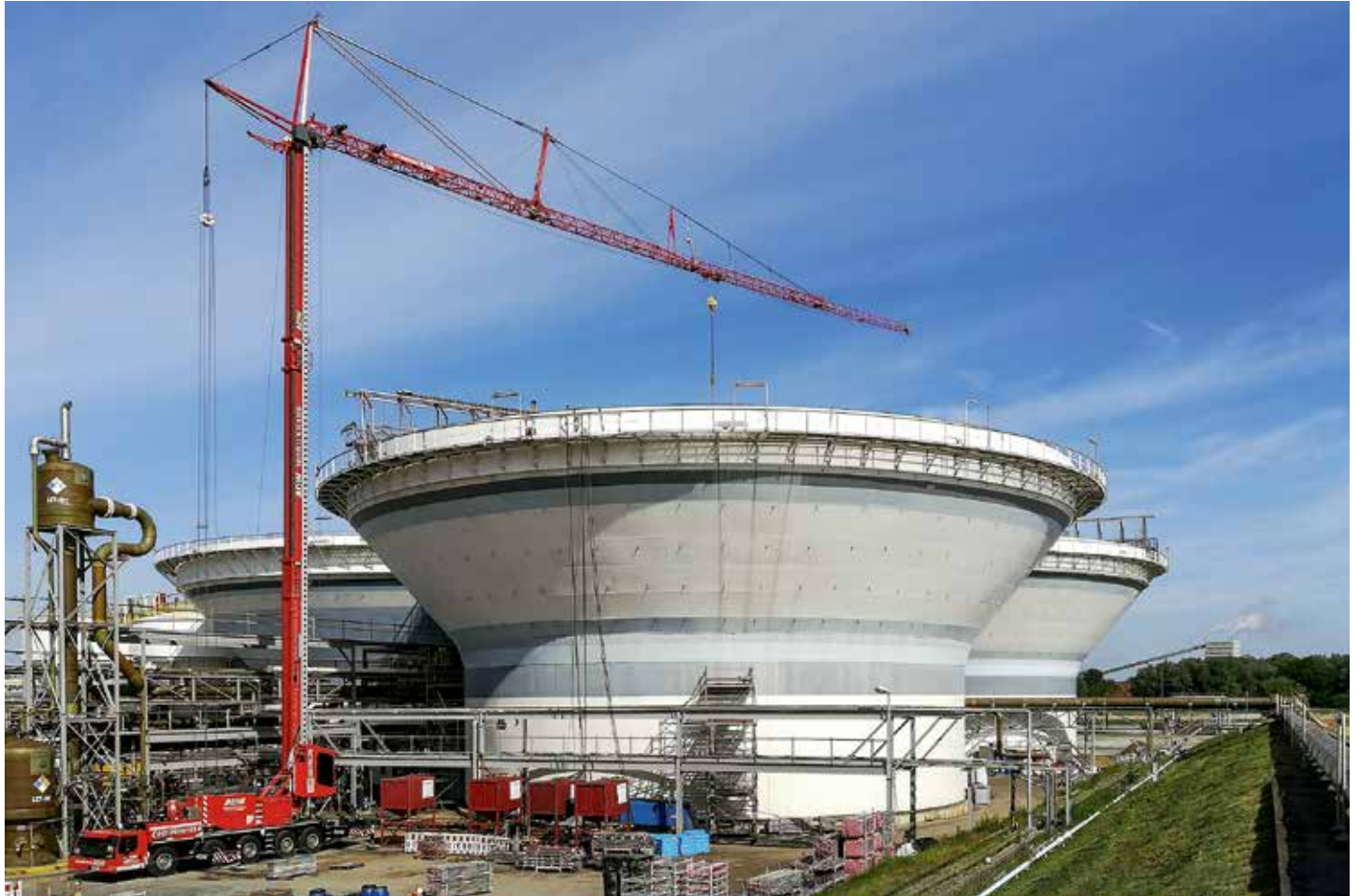
Mit seiner maximalen Ausladung von 58,5 m im Katzmodus konnte der MK 140 die Fläche des Reaktors gut abdecken.
