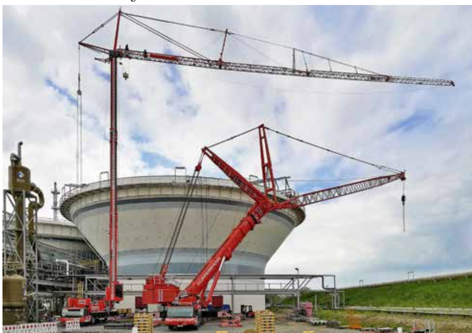
Für die besonders schweren Teile wie die Räumerbrücken bekam der Mobilbaukran MK 140 zeitweise Unterstützung von einem LTM 1500-8.1.
