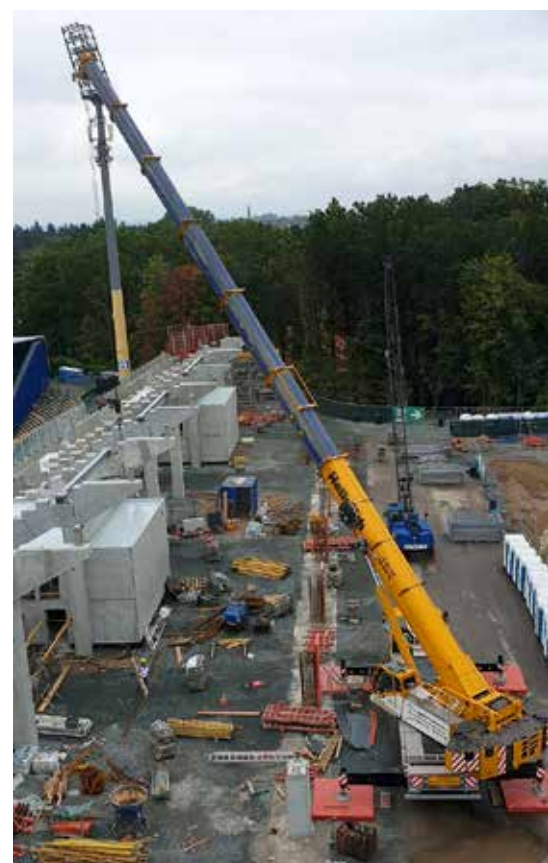
Der Grove GMK 5250L beim Einhub der Tribünen-Segmente.
