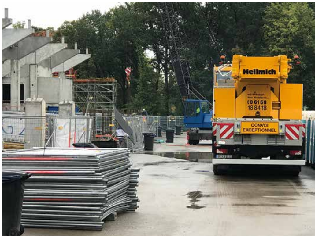
Ein Mobilkran wird auf der engen Baustelle in Stellung gebracht.
