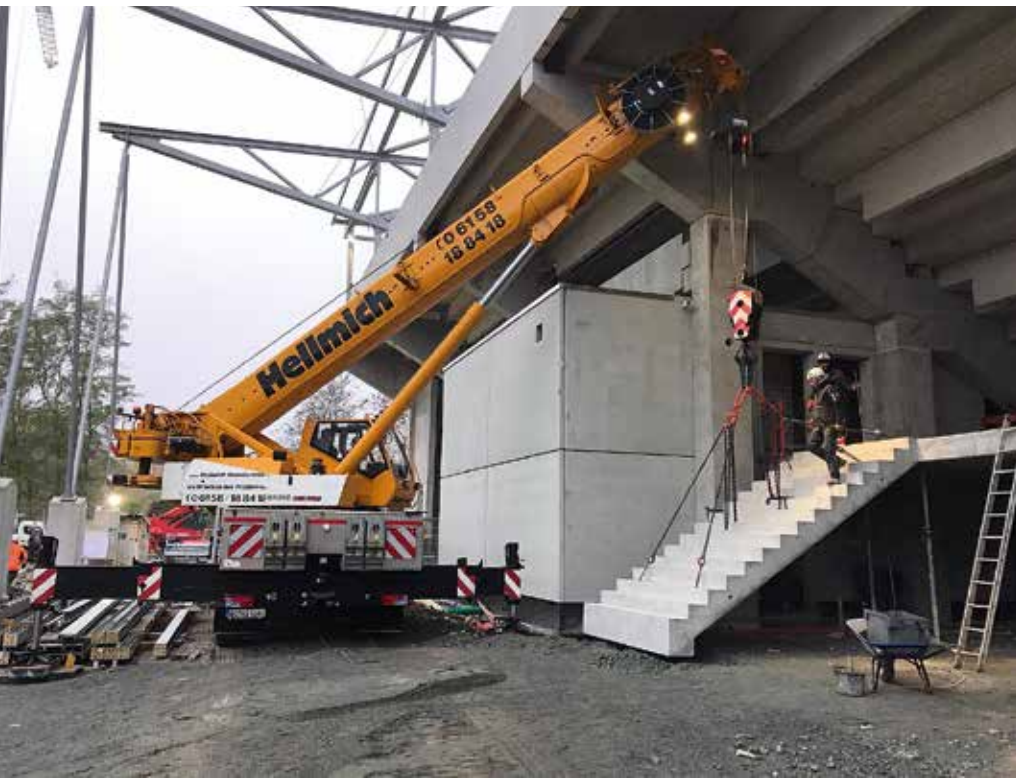
Hellmichs 80 t Autokran beim Einhub der Treppenläufe auf der Tribünen-Rückseite.
