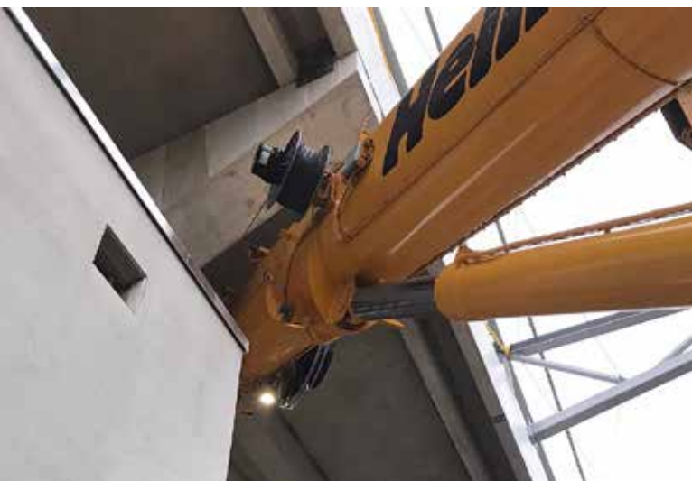
Millimeterarbeit beim Einhub der Treppenläufe.
