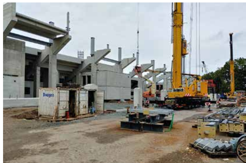
Platzvorteil Liebherr MK110: wenig Aufstellraum und nah am Bauwerk.
