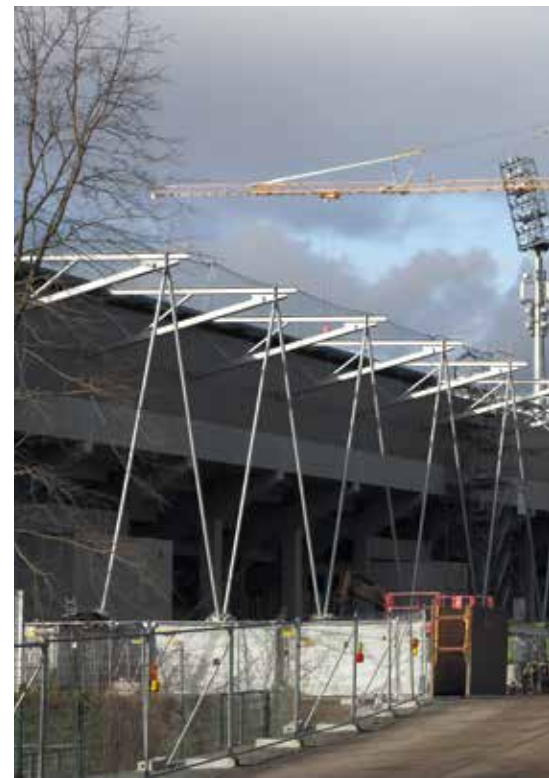
Der Liebherr MK 110 beim Einhub des Tribünenendaches.
