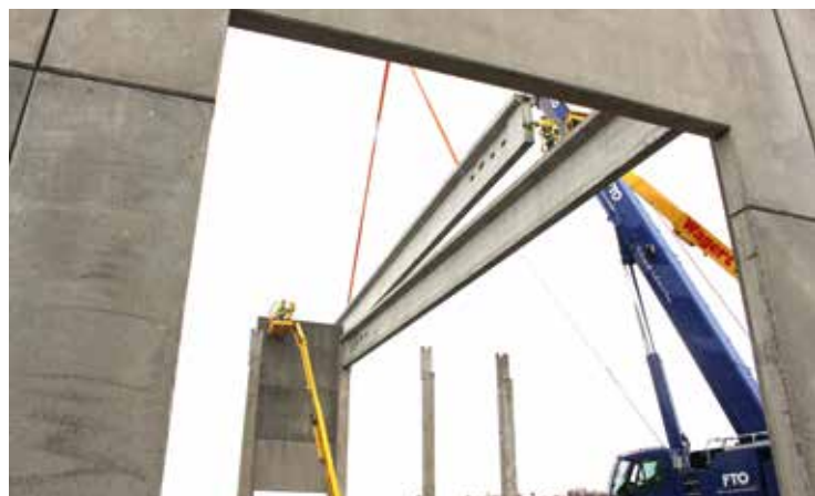
Bei den Montagearbeiten half auch eine Teleskoparbeitsbühne.
