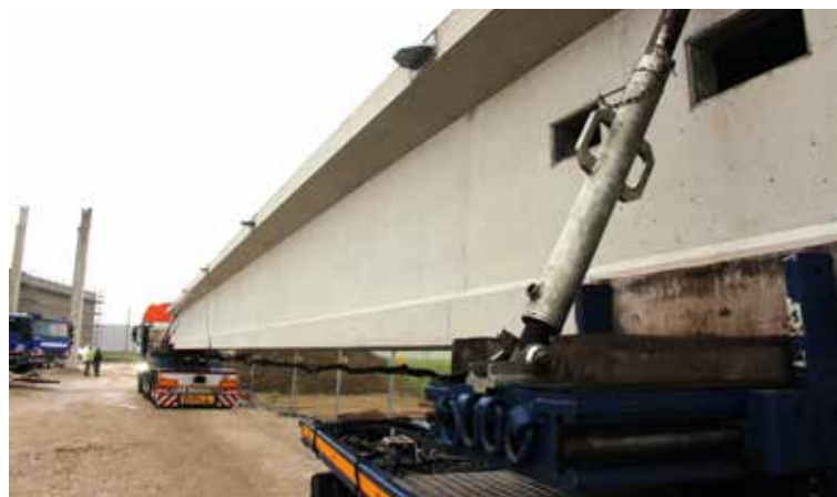
Die von FTO gefertigten Spannbetonträger wurden von Universal Transport auf mehreren Nachläuferkombinationen angeliefert.
