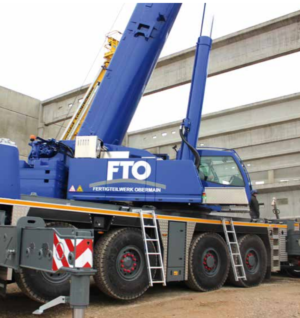
Der Tadano ATF 220G-5 beim Hub einer der 35 t schweren Spannbetonträger.
