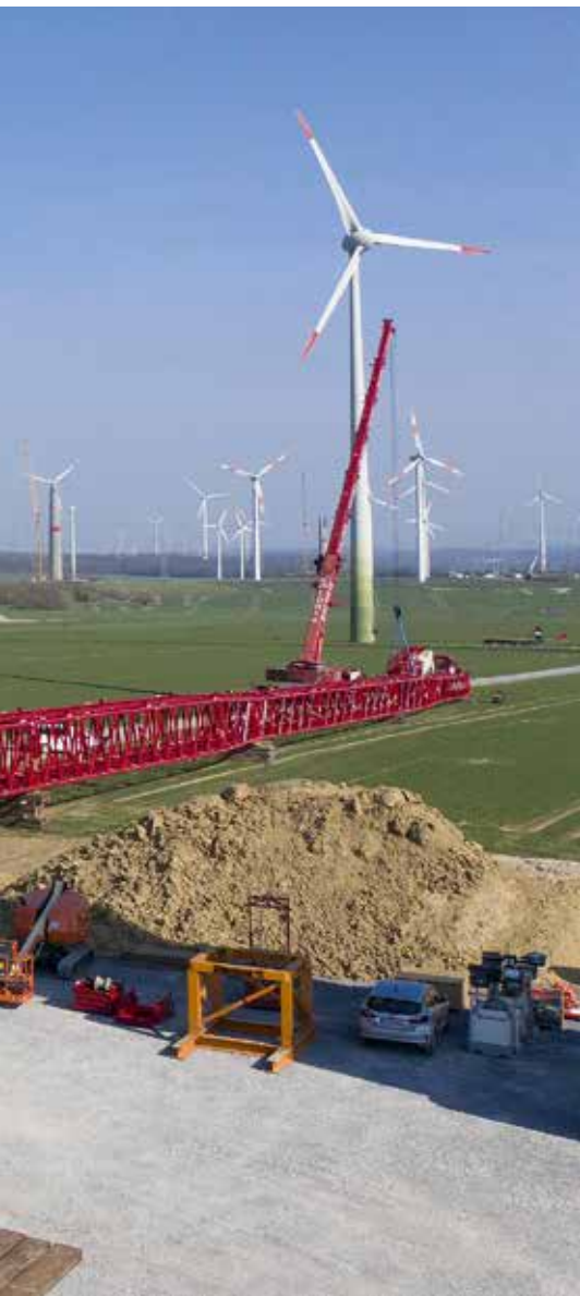
... und hinten der Hauptmast zusammengebaut.
