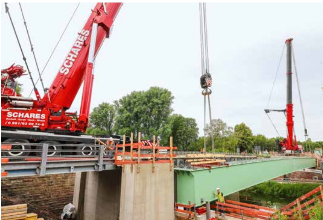
Die 168 t schweren Stahlträger werden feinfühlig auf den Widerlagern abgelegt.
