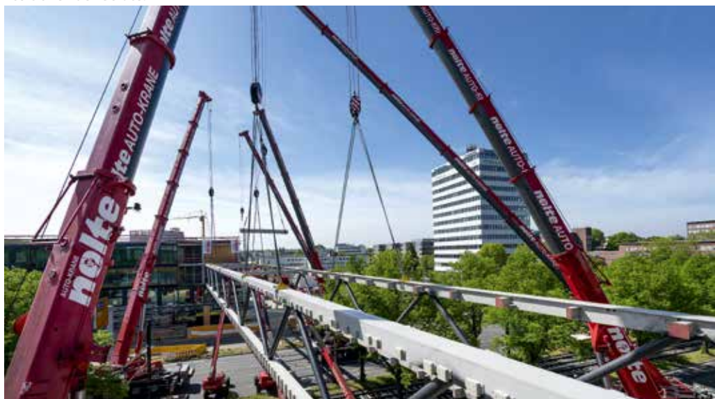
Fast geschafft: noch halten die vier größeren Liebherr-Mobilkrane die einzelnen Fachwerkkonstruktionen der zukünftigen Gebäudeverbindung. Zwei weitere Krane bauen währenddessen die Querverbindungen ein.
