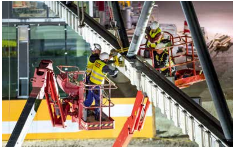
Die riesigen Teile werden vom Stahlbauteam miteinander verbolt.
