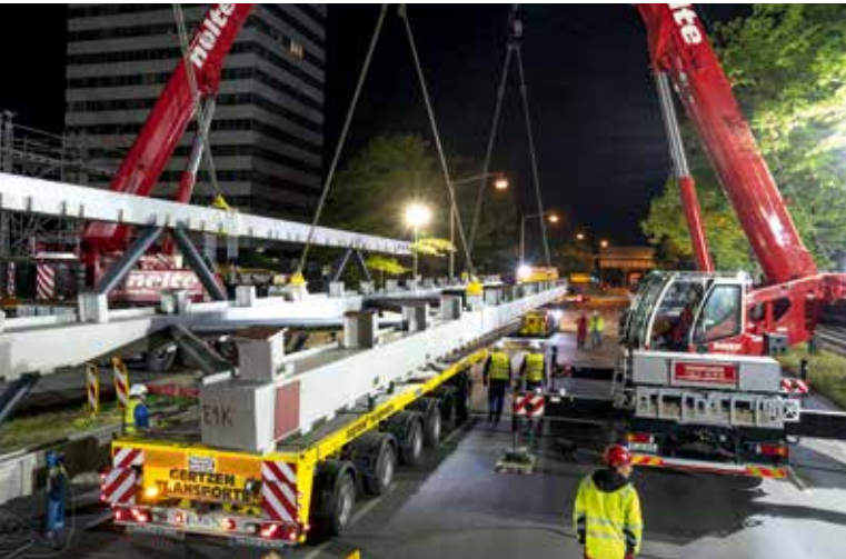
Raumnot: unter eingeschränkten Platzverhältnissen müssen die vier Fachwerkkonstruktionen abgeladen und vertikal gestellt werden.
