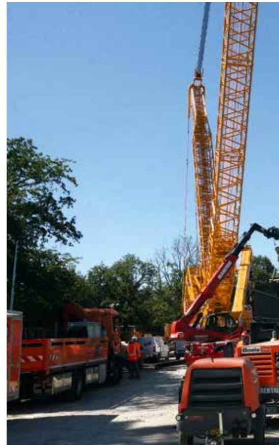
Letzte Arbeiten an der Brücke werden noch ausgeführt.
