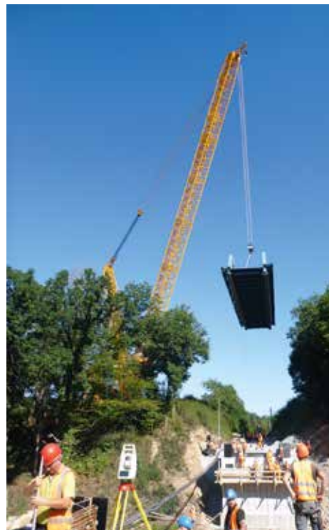
Netto 165 t wiegt die neue Eisenbahnbrücke, die hier in Richtung des Baufeldes geschwenkt wird.
