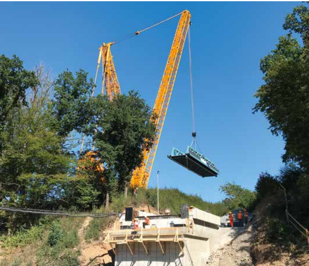
Blick vom Baufeld: Die Brücke kommt näher.
