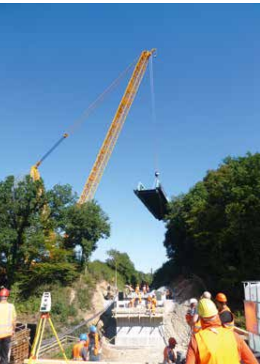
Netto 165 t wiegt die neue Eisenbahnbrücke, die hier in Richtung des Baufeldes geschwenkt wird.
